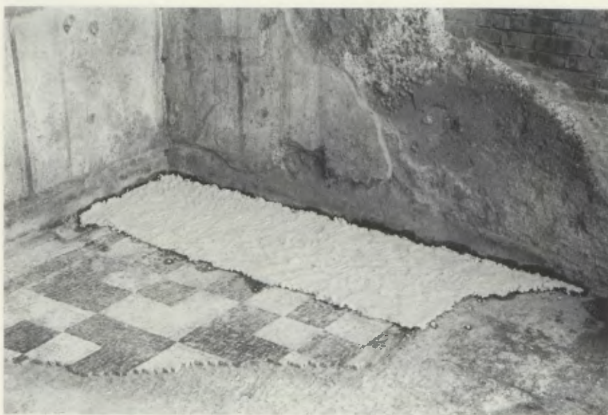
5. Impacchi di carbonato di ammonio e EDTA sul mosaico della taberna 2 (Archivio fotografico Mercati di Traiano).
