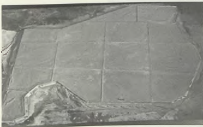
Πλαίσιο με αλουμινοκατασκευή. Πλήρωση πίσω πλευράς με κονίαμα.
