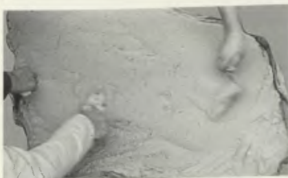
Εφαρμογή τελικού στρώματος κονιάματος.
