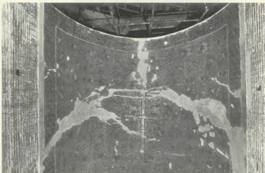
1. Rotonde de Thessalonique, voûte de la niche sud.
