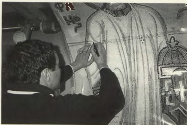
2. Σχεδιαστική αποτύπωση των τμημάτων προς αποκόλληση σε κλίμακα 1:1.
