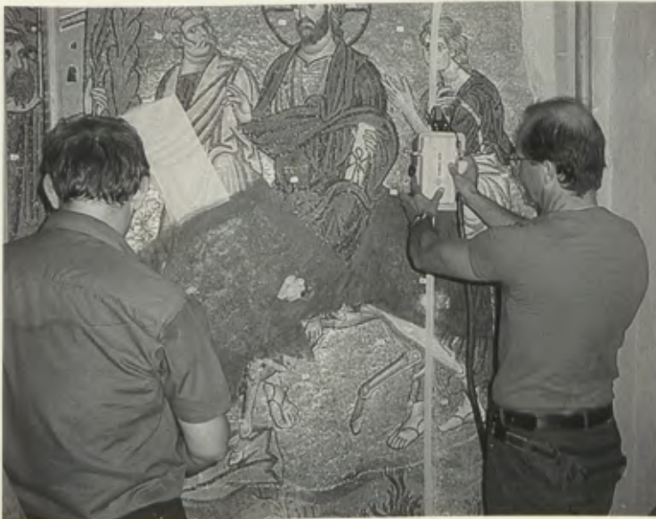
6. Ανίχνευση με γεωρατάρ για τη διαπίστωση και την ακριβή θέση των κενών μεταξύ των υποστρωμάτων.
