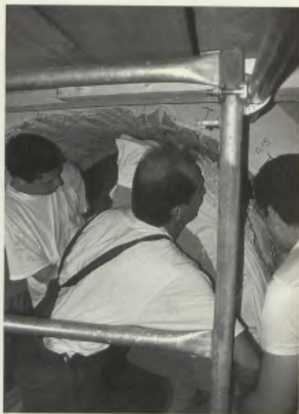
4. Αποτοίχιση τμήματος εσωραχίου τόξου.
