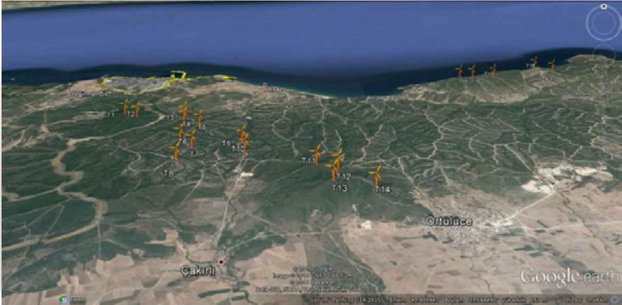
Şekil 3 İçdaş Biga RES Türbinlerinin Arazideki Konumları
