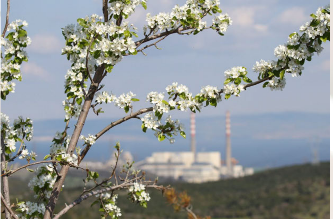
Fotoğraf 1 RES sahasından Tesis Genel Görünüm
