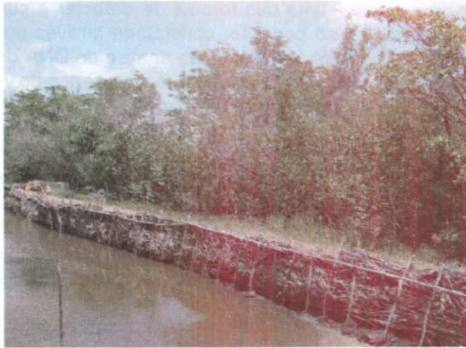
Figura 2 - Estrutura da construção de alguns diques utilizados na carcinicultura de Litopenaeus vannamei , no Rio Grande do Norte.
