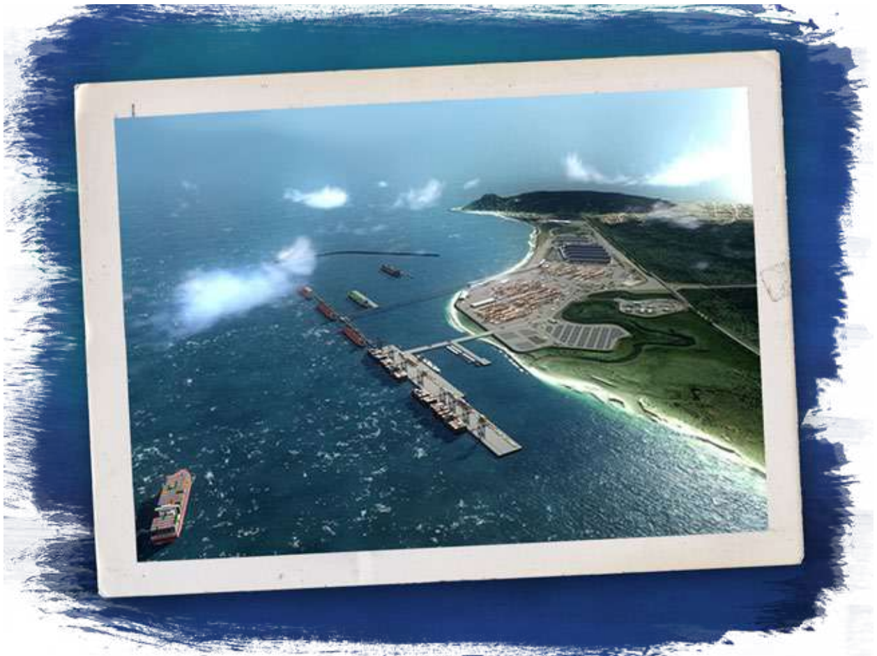
Figura 8.4 – Projeto do futuro Porto Brasil Sul em São Francisco do Sul, Santa Catarina (fonte: portobrasilsul.com.br).
