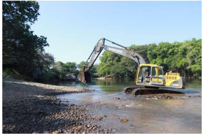
**Construcción de represa temporal en el río Santamaría, en el punto de captación de agua cruda de la planta de Santiago.**
