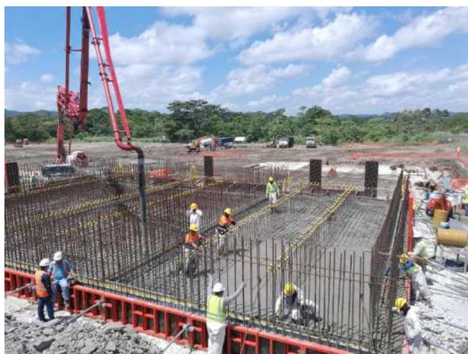
**Vaseado de concreto en nuevo módulo para potabilización de agua, en la Planta potabilizadora Federico Guardia Conté (Chilibre).**
