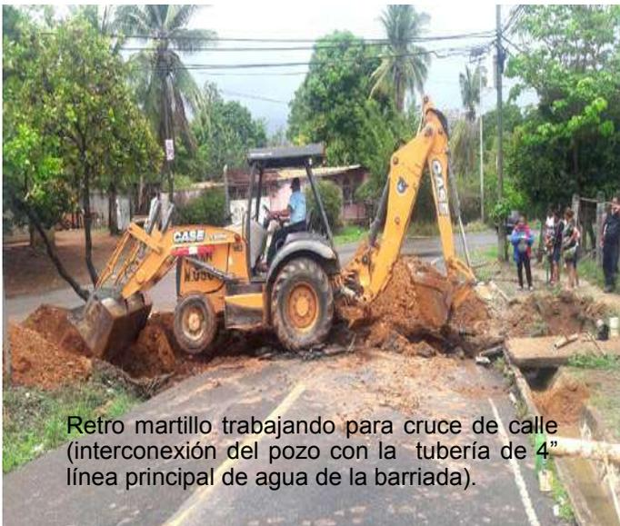
Retro martillo trabajando para cruce de calle (interconexión del pozo con la tubería de 4” línea principal de agua de la barriada).
