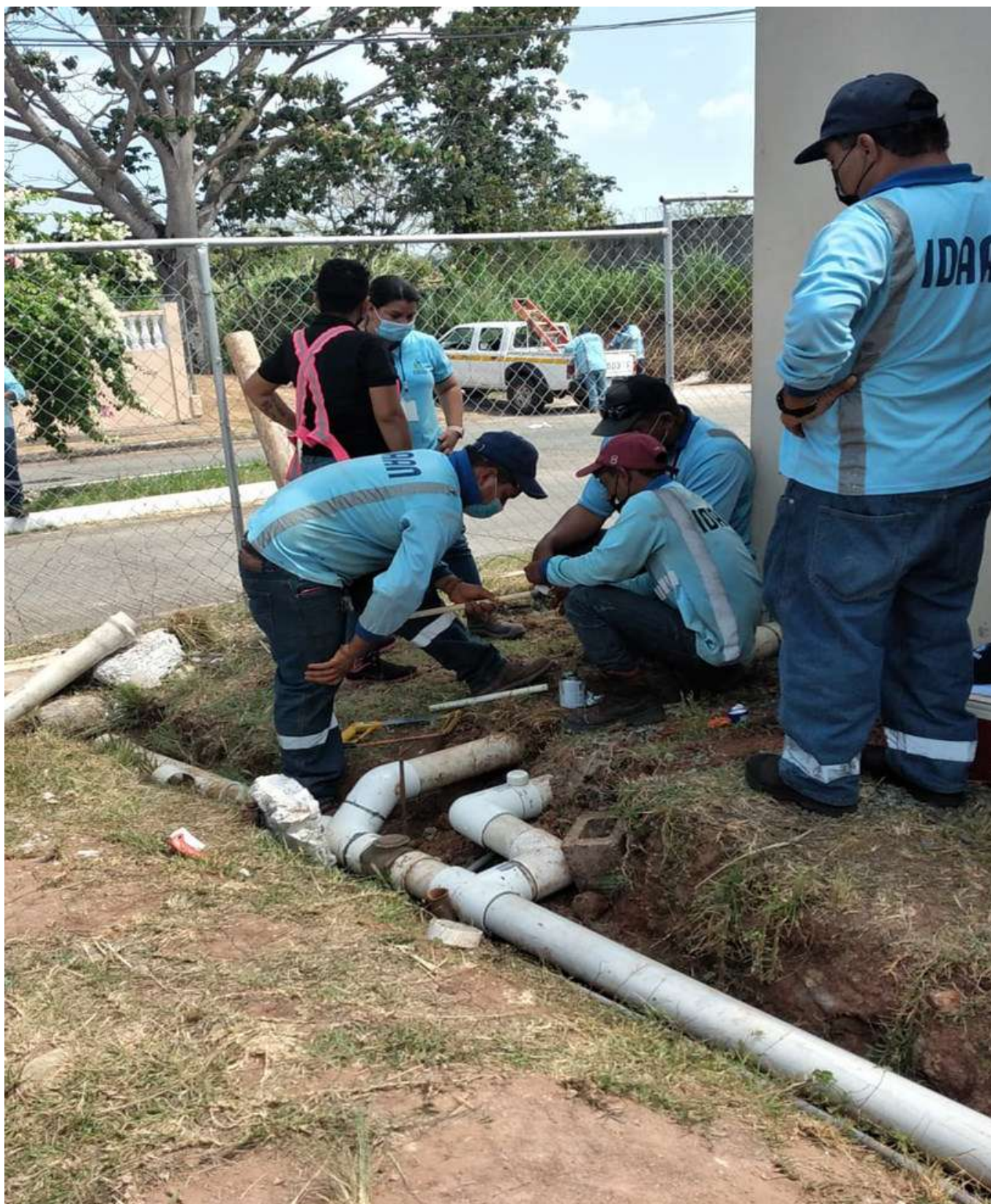
Interconexión de la estación de bombeo de la Barriada Residencial Don Juan a la línea de distribución existente.
