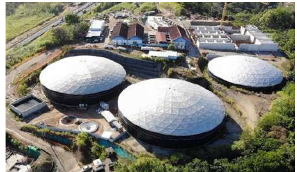
Avance del Proyecto Sabanitas II
