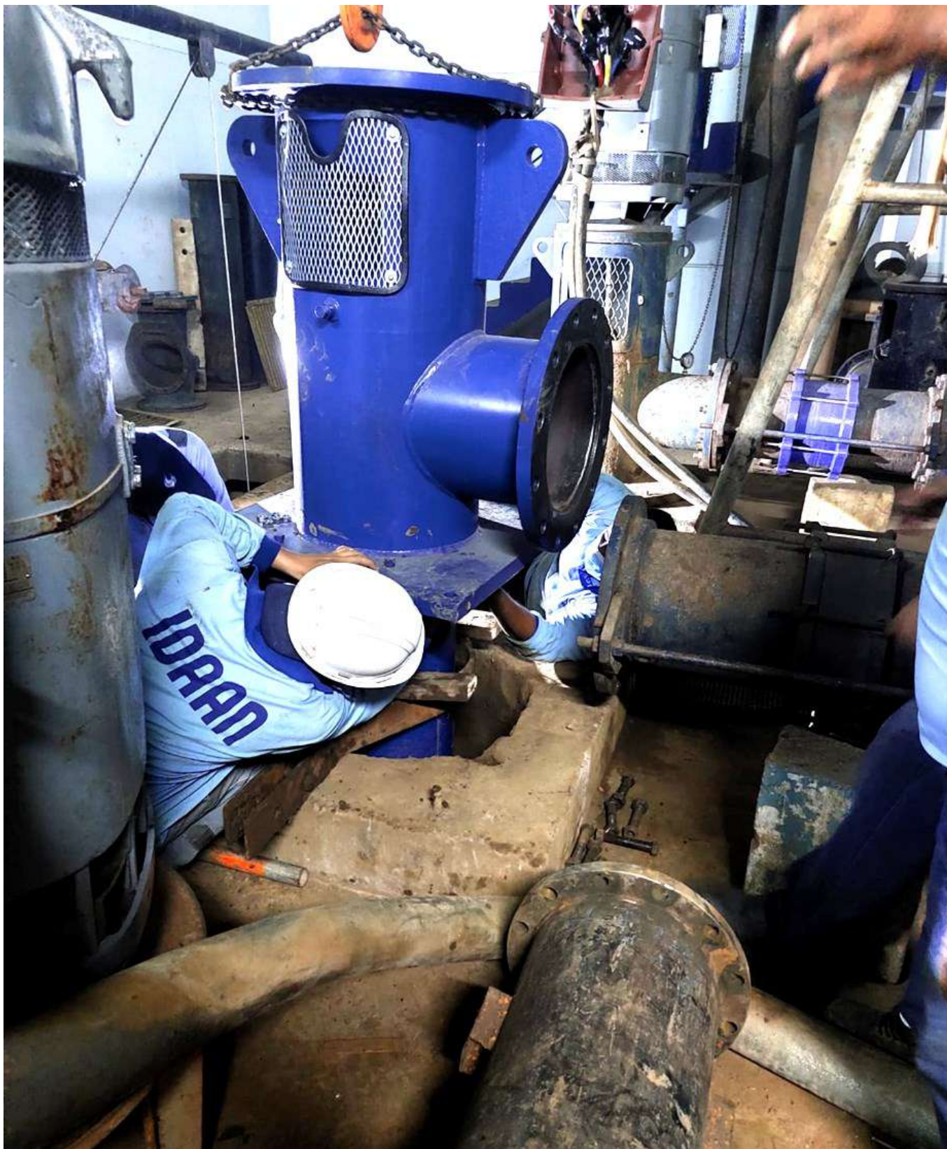
Instalación de bombas tipo turbina vertical de la Toma de Agua Cruda de La Chorrera.
