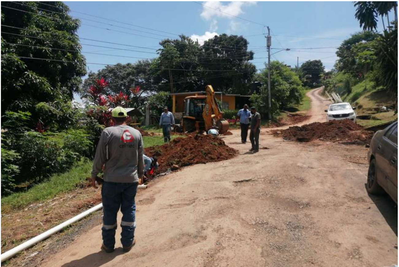
Rehabilitación de las líneas de distribución del Sector de Bello Horizonte abastecido con la nueva estación de bombeo.
