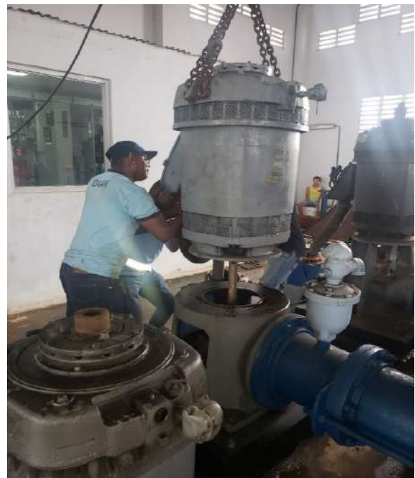
Proceso de reemplazo de motor de 250HP en la Planta Centenario.
