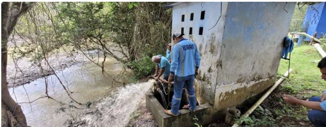
Instalación de equipo de bombeo para limpieza de fosa de succión de agua cruda de la Planta Potabilizadora de Macaracas.
