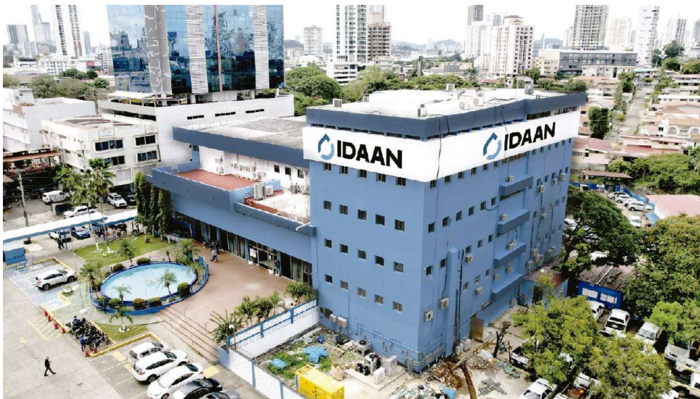
Trabajos de pintura y resane del Edificio Sede.
