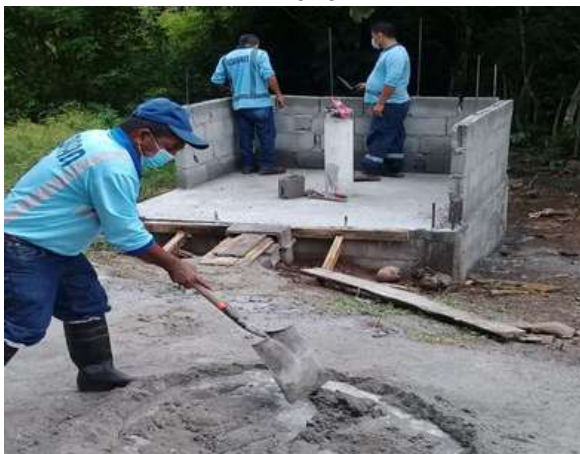
Construcción de caseta de Pozos.
