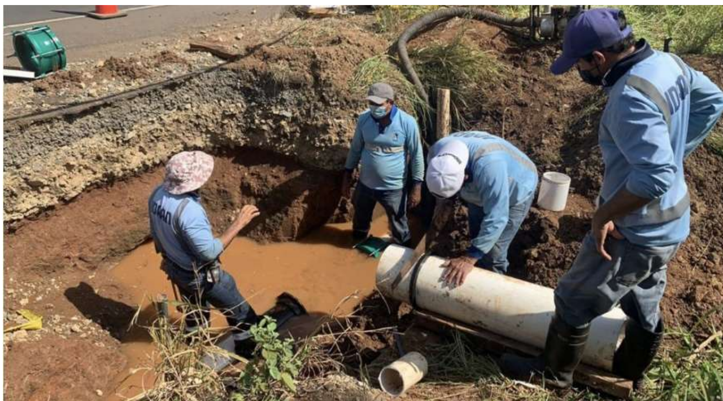
Reparación de fuga de agua potable en red de distribución-Guararé.
