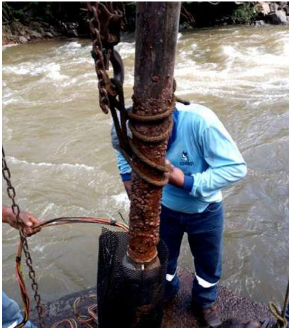
Mantenimiento a equipos de Bombeo.
