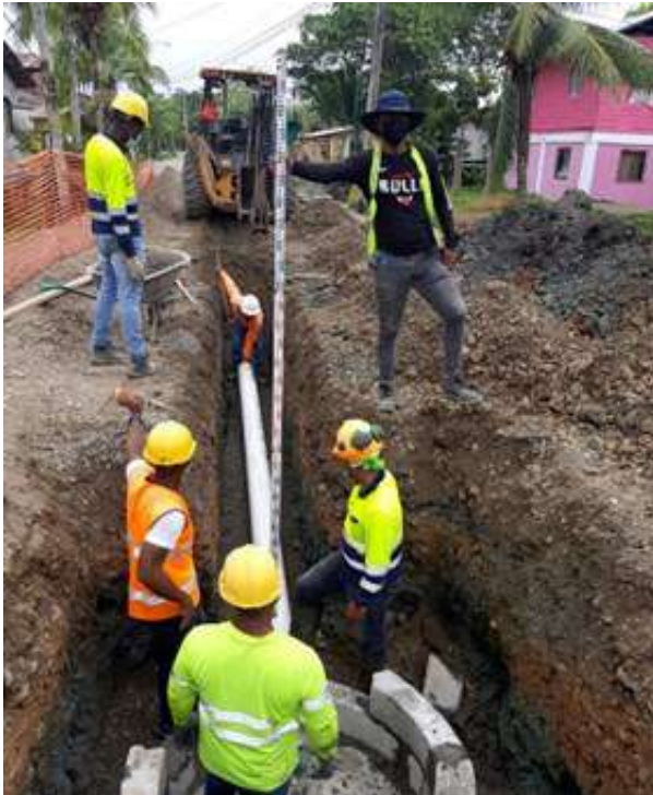
Conexiones Intradomiciliarias y Red de Alcantarillado
