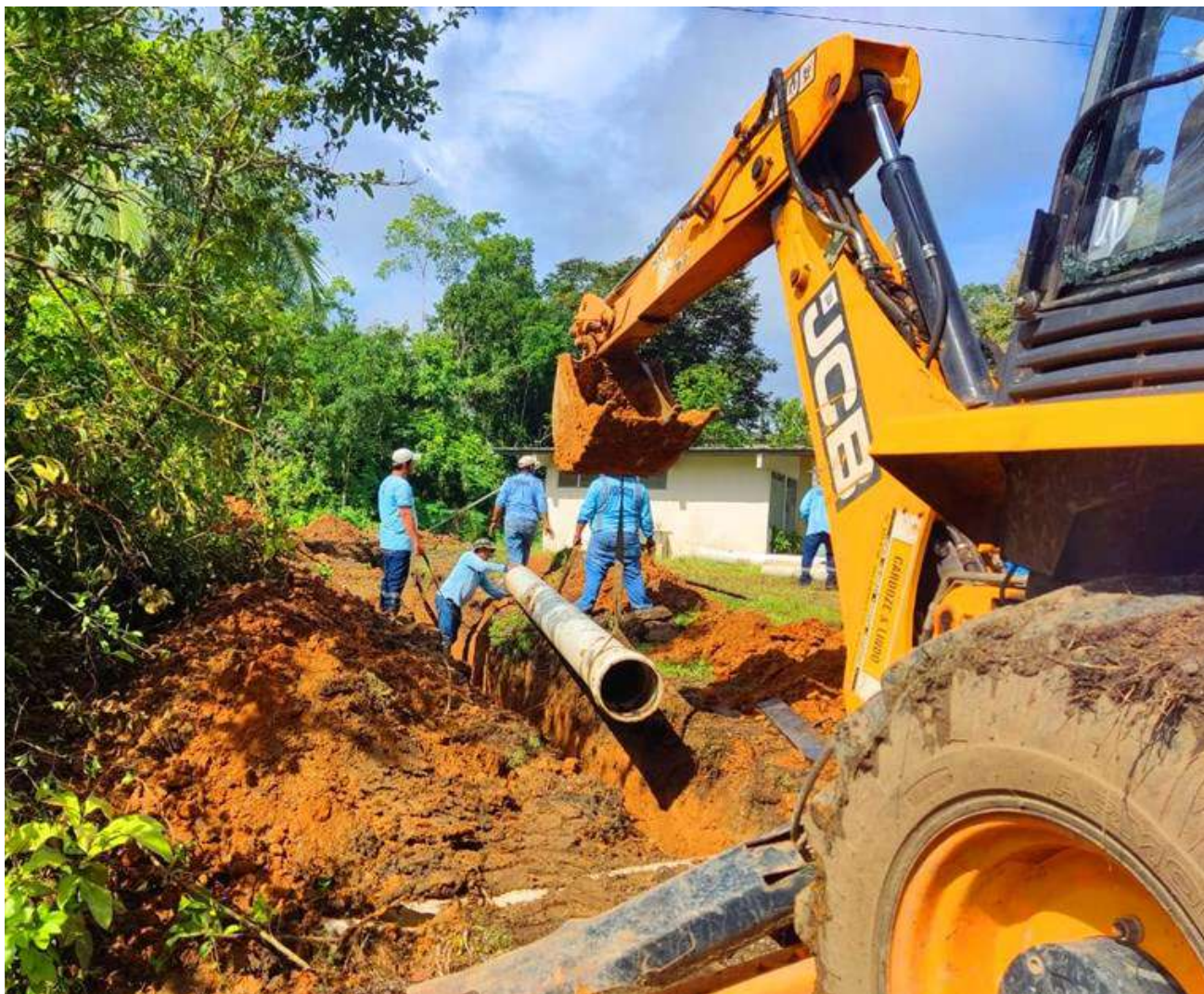
Trabajos de mejoras en el sistema de conducción de la Planta Potabilizadora de San Bartolo, Barú.
