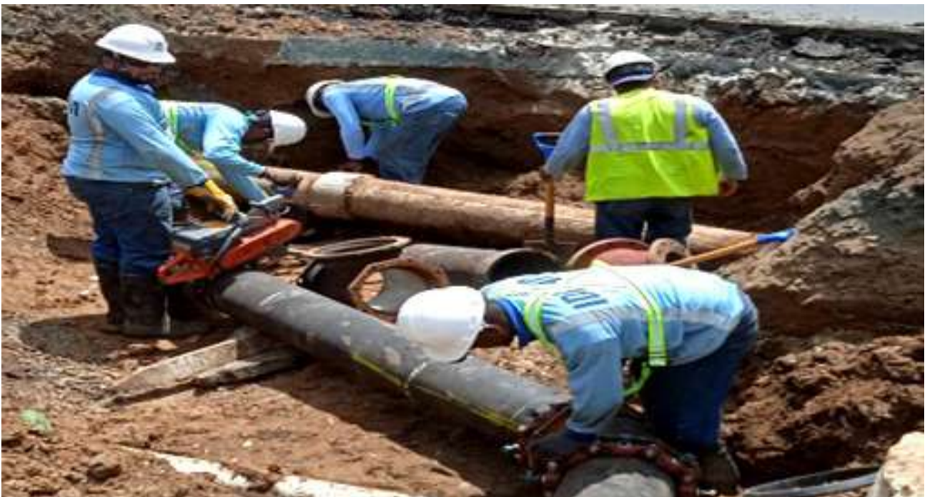
Interconexión de tubería de 24'' en Chilibre.
