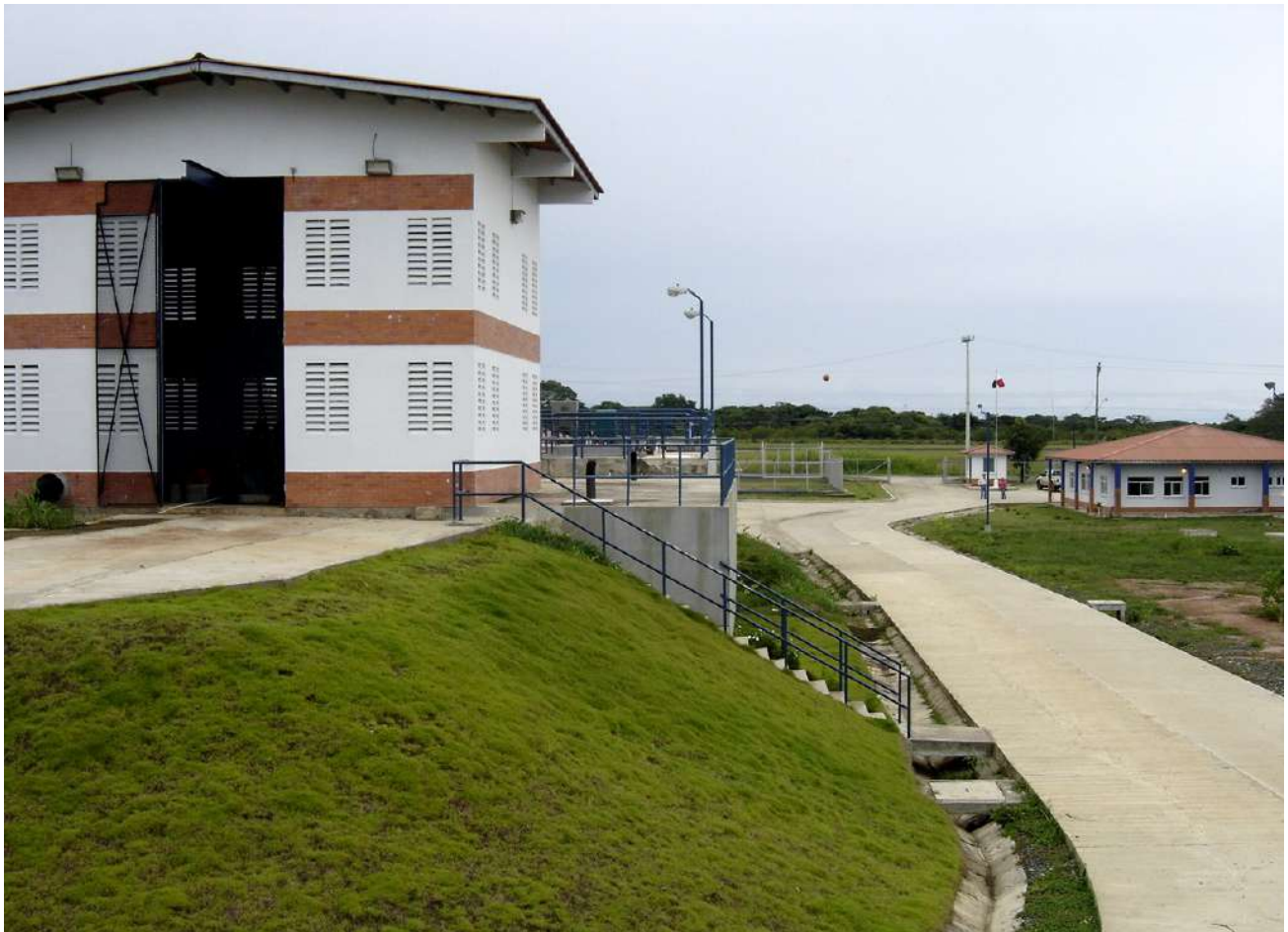
Planta Potabilizadora de Farallón.
