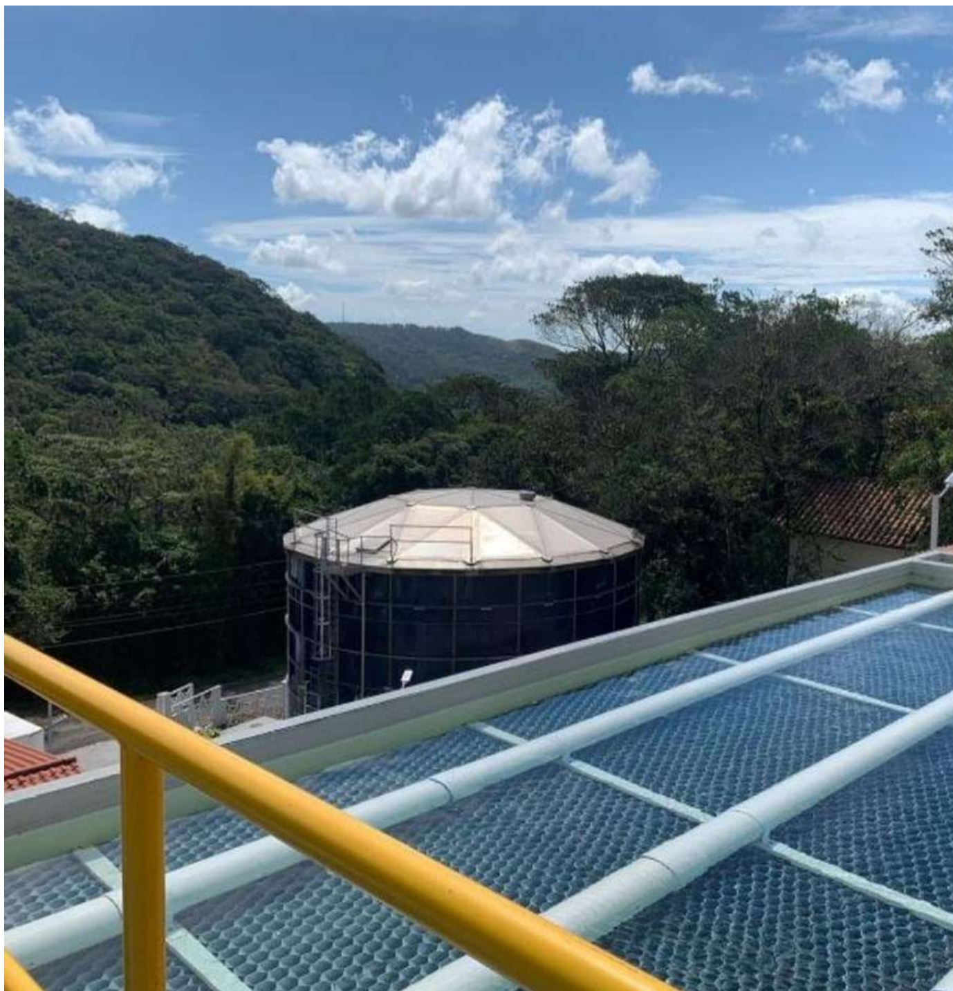
Planta de tratamiento de agua potable del nuevo acueducto del Valle de Antón.
