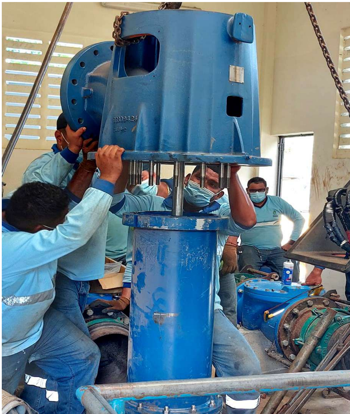
Instalación de las bombas tipo turbina vertical de la toma de agua cruda de Chame.
