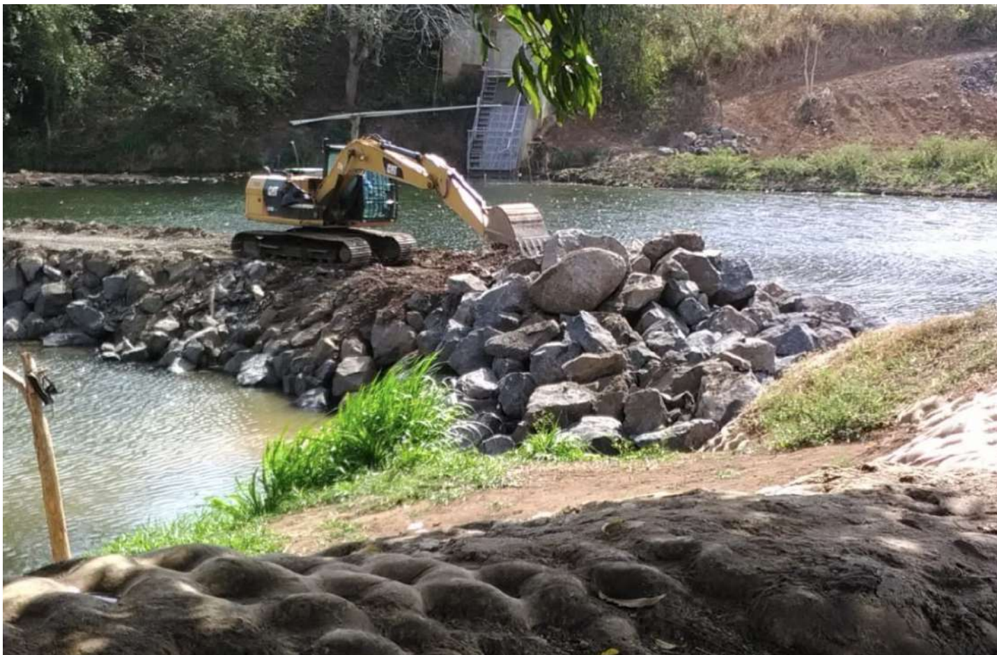
Trabajos de rehabilitación de presa fusible en la Toma de Agua Cruda de la Planta Potabilizadora Rufina Alfaro.
