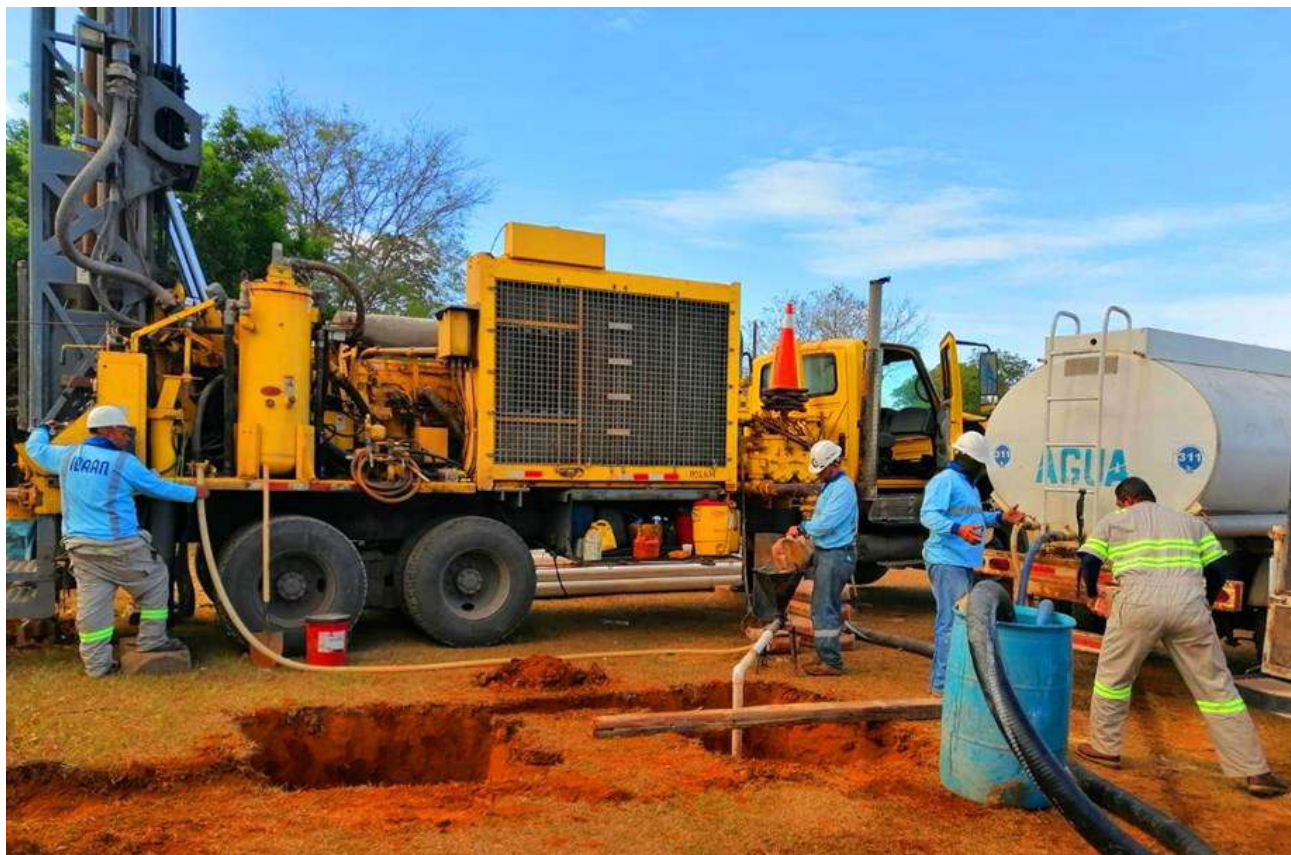
Perforación de dos fuentes de aguas subterráneas en Las Lomas, David.
