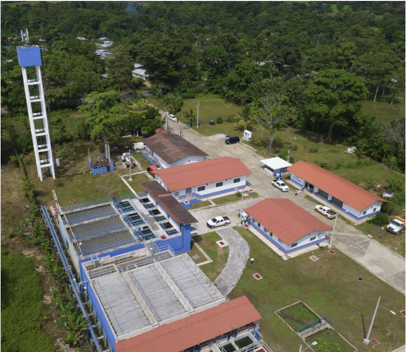
Planta Potabilizadora de Villa Darién.
