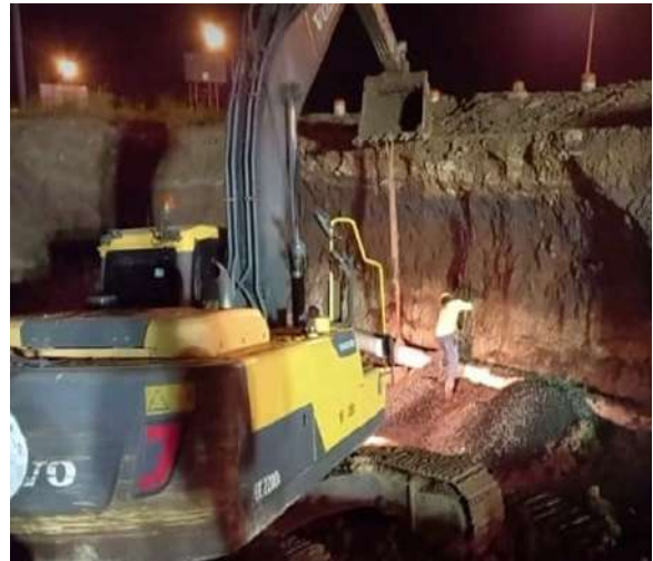
Reparación 6", vía Panamericana.
