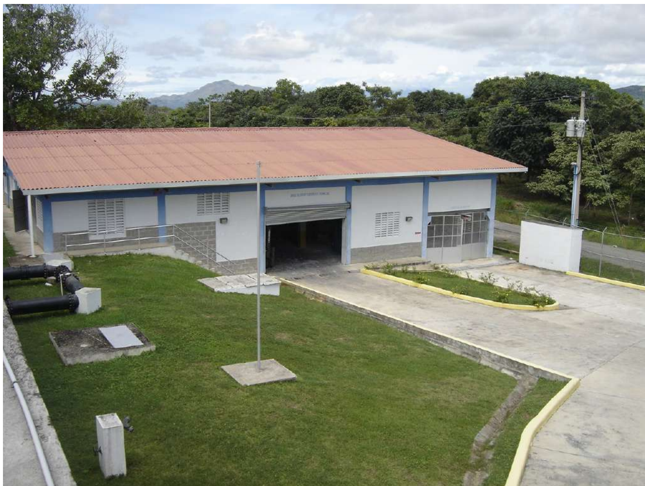
Planta Potabilizadora de Penonomé.
