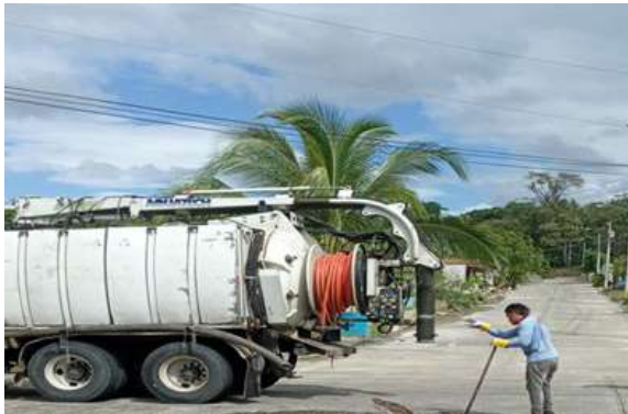
Desobstrucción de línea sanitaria en Santa Teresa Alcalde Díaz.
