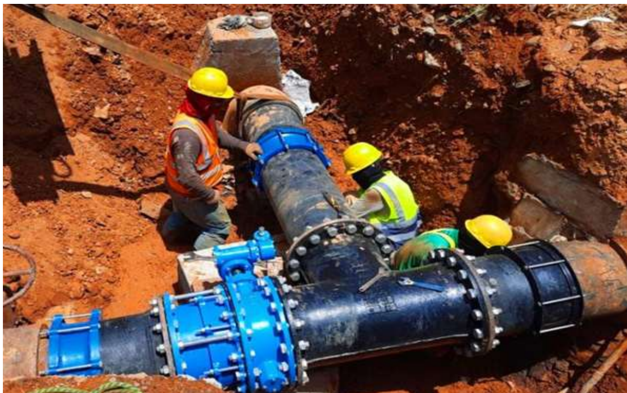
Trabajos de interconexión del proyecto David Fase 1.
