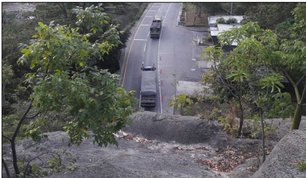
Fotografía 3 Fragmento vial del túnel de Sumapaz.
