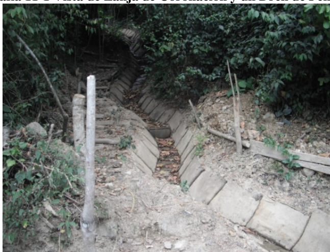
Fotografía 11-1 Vista de Zanja de Coronación y un Dren de Penetración
