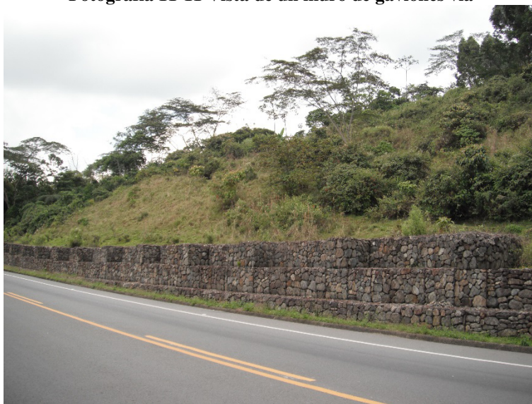
Fotografía 11-11 Vista de un muro de gaviones vía
