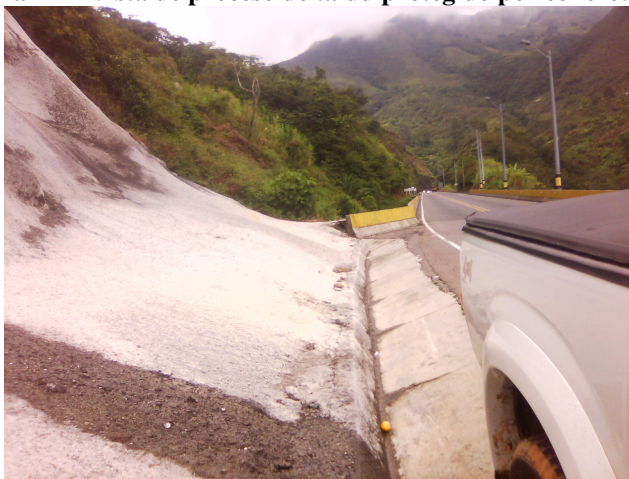
Fotografía 11-4 Vista de proceso de talud protegido por concreto lanzado
