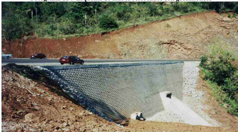
Fotografía 11-9 Esquema de muros reforzados con geosintéticos
