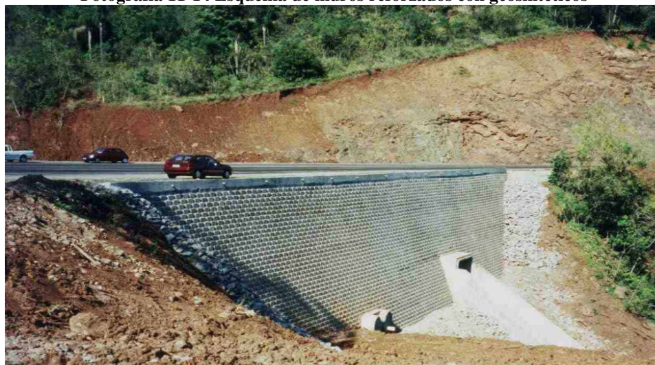
Fotografía 11-14 Esquema de muros reforzados con geosintéticos
