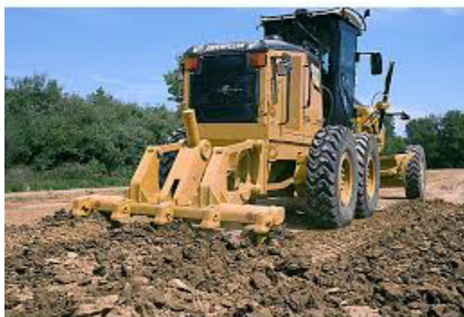
Fotografía 11-20 Proceso de escarificación mecánica del suelo
