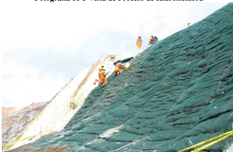
Fotografía 11-3 Vista de Proceso de Hidrosiembra
