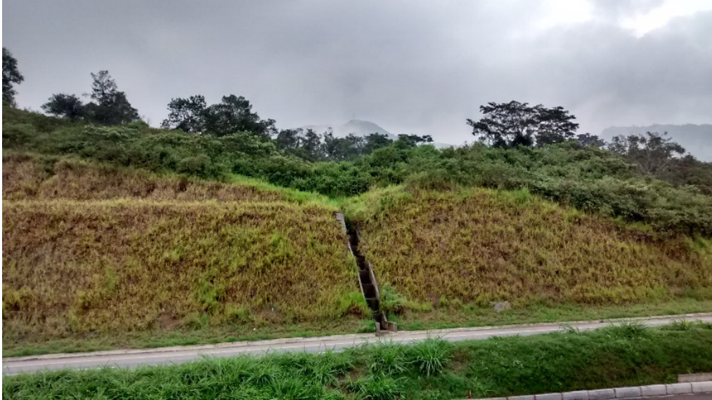
Fotografía 11-10 Vista de un descole de un sistema de cunetas colocadas en un corte vial
