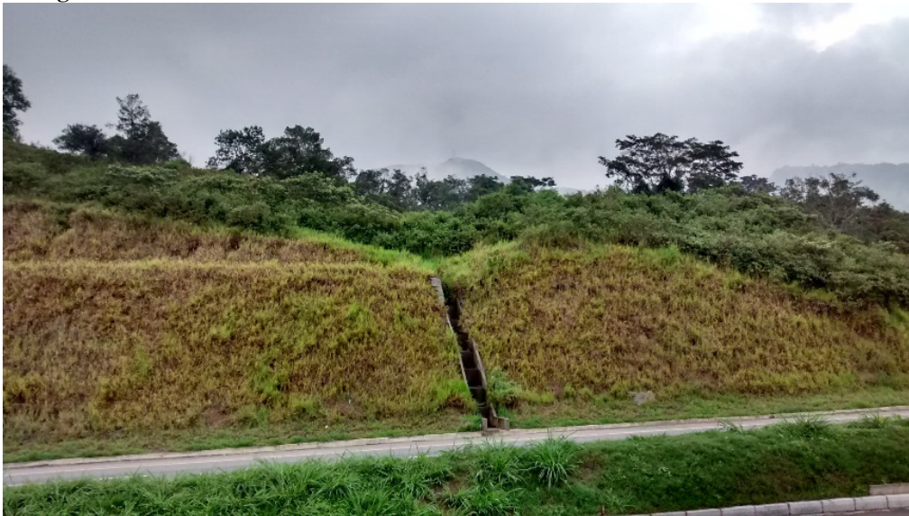
Fotografía 11-15 Vista de un descole de un sistema de cunetas colocadas en un corte vial
