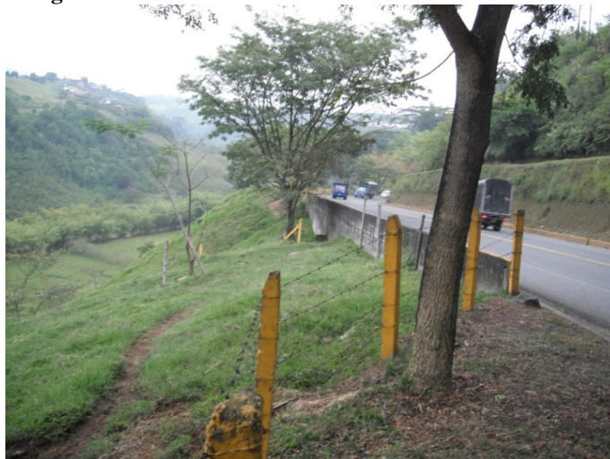
Fotografía 11-8 Vista de un muro de concreto a borde de vía
