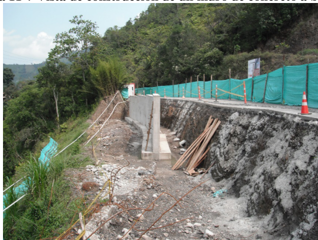
Fotografía 11-7 Vista de construcción de un muro de concreto a borde de vía
