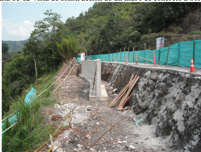
Fotografía 11-12 Vista de construcción de un muro de concreto a borde de vía
