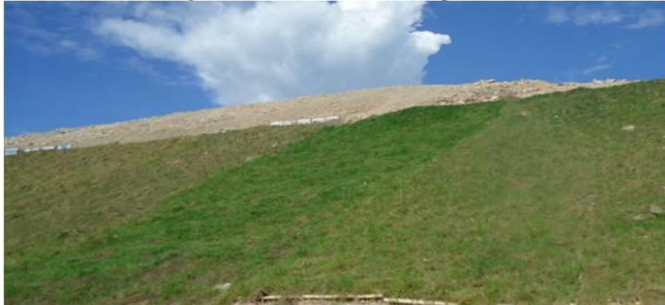
Fotografía 11-5 Vista de un talud empradizado
