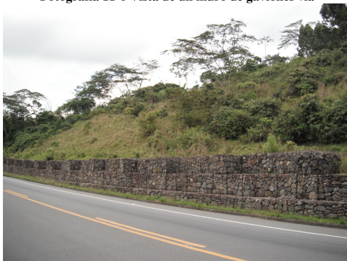
Fotografía 11-6 Vista de un muro de gaviones vía
