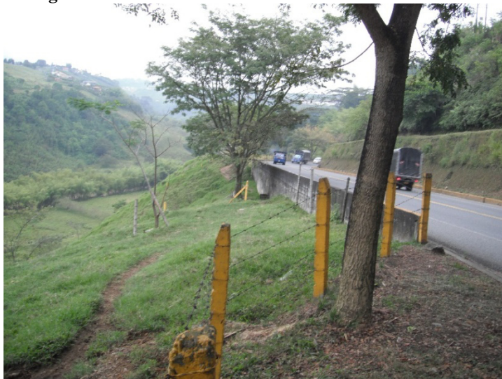
Fotografía 11-13 Vista de un muro de concreto a borde de vía
