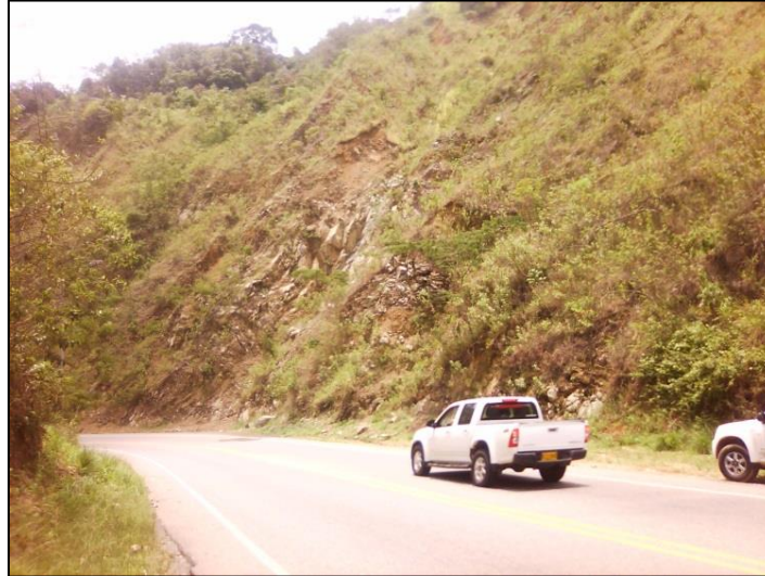
Fotografía 2-1 Estado de la vía actual en las Unidades Funcionales
