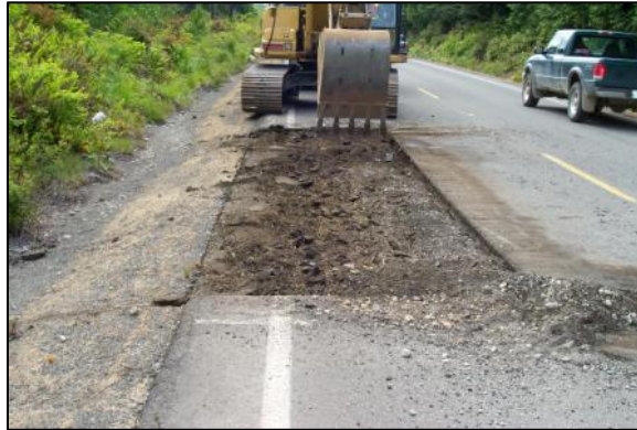
Fotografía 2-4 Excavación para el parcheo de un pavimento asfáltico
