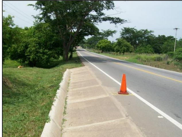
Fotografía 2-15 Cuneta tipo para carreteras
