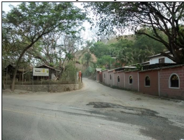
Fotografía 3-2 Acceso a trituradora Santa Fe, vereda Los Almendros del municipio de Sopetrán
