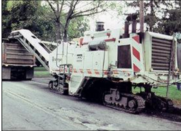
Fotografía 2-6 Fresado de un pavimento asfáltico
