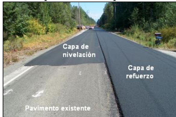
Fotografía 2-5 Capa de nivelación previa a una capa de refuerzo
