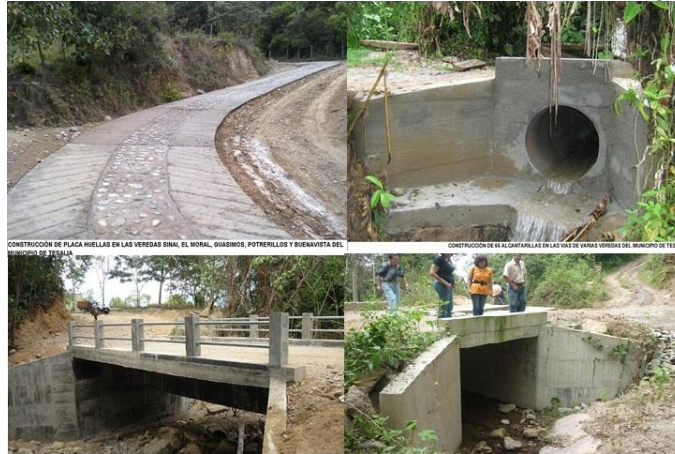
Fotografía 2-16 Alcantarillas de tubo, box culvert y puentes
