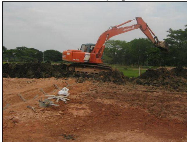
Fotografía 2-3 Demolición y explanación en carreteras
