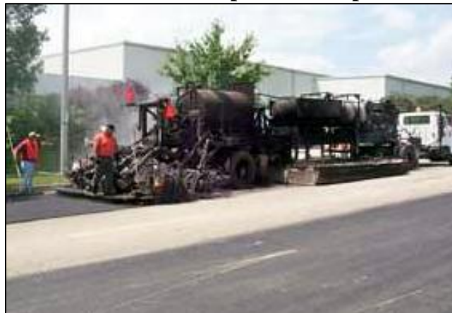
Fotografía 2-12 Termo - reperfilado de pavimento asfáltico
