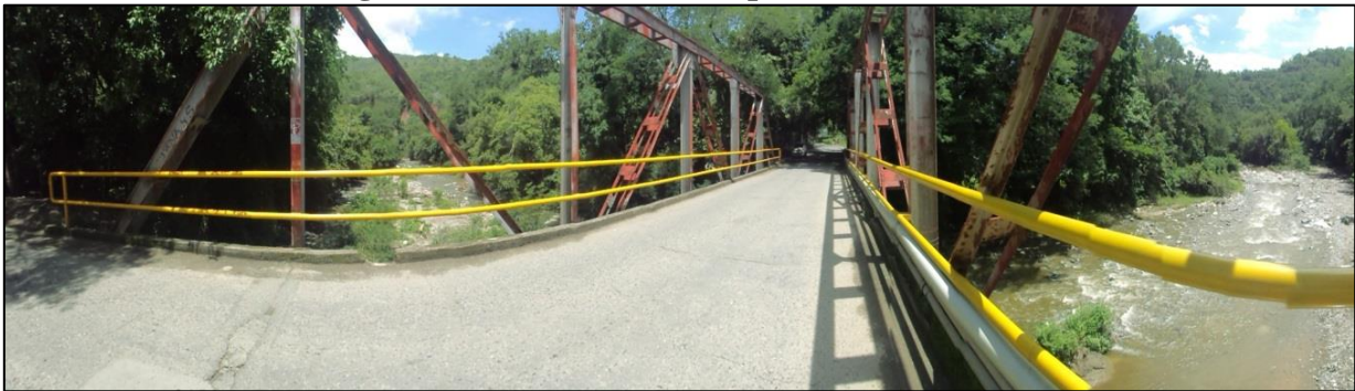
Fotografía 7-2 Acceso captación río Aurrá
