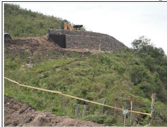
Fotografía 2-19 Muro de contención en gaviones
