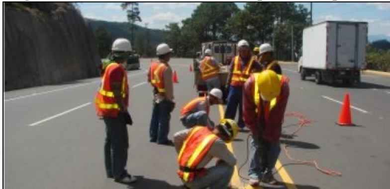
Fotografía 2-21 Señalización en superficie de pavimento
