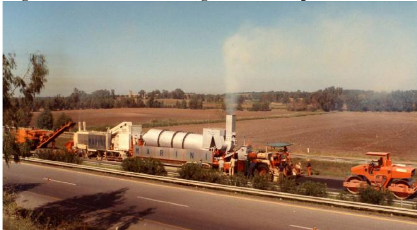
Fotografía 2-13 Termo-regeneración de pavimento asfáltico
