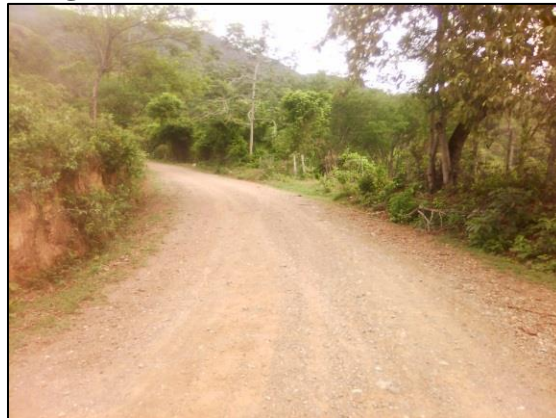
Fotografía 2-22 Acceso a ZODME 14
