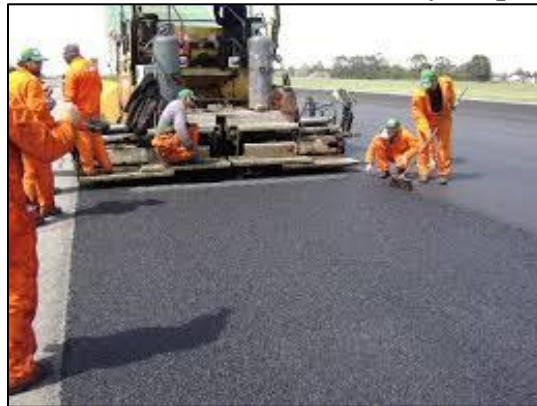
Fotografía 2-14 Colocación de base y carpeta asfáltica
