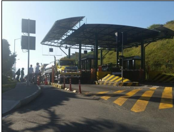
Fotografía 3-4 Tránsito de vehículos sobre vía existente
