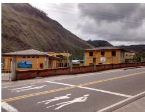
Fotografía 2 Vía tipo 1 - Panamericana. Coordenadas: E: 955390 – N: 603185.
