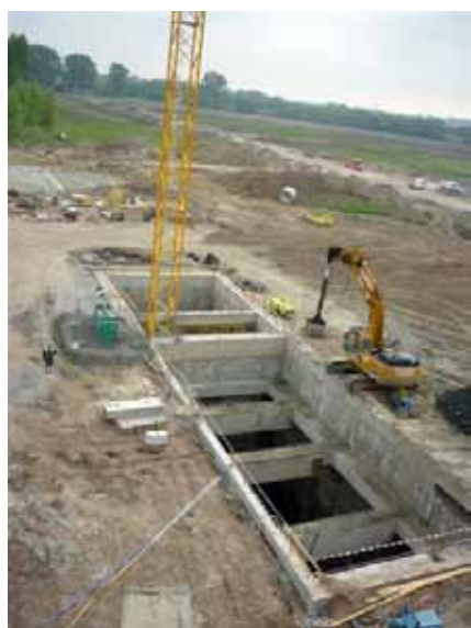
Travaux d'aménagement de la station de démergement et d'assainissement de la ZAEP de Mons
