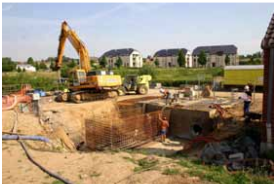
Travaux d'extension de la station d'épuration de Saint-Vaast
