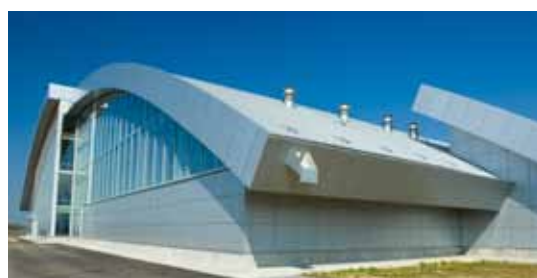
Station de potabilisation d'Ecaussinnes
