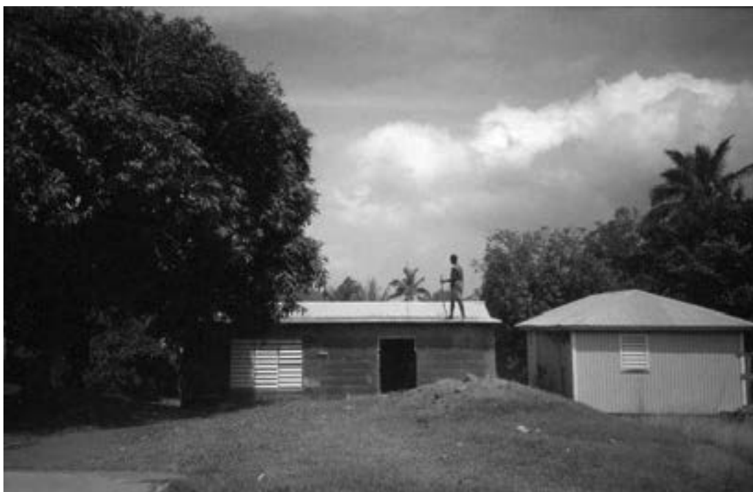
Fig. 6. La limpieza de la ceniza volcánica depositada en los tejados es fundamental para evitar el colapso de los techos.
