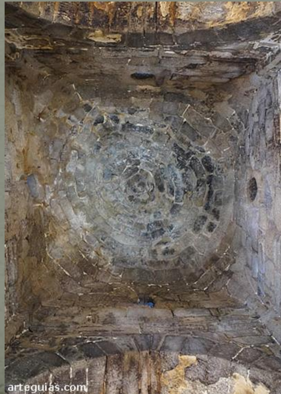
Cúpula sobre el crucero
