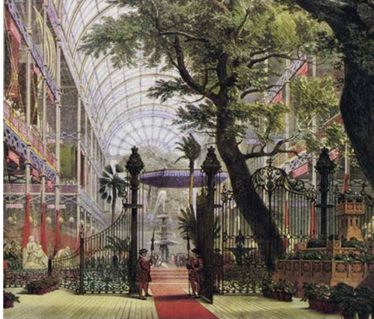
[Fig. 5] Palácio de Cristal – Hyde Park, Londres. Interior mostrando as guarnições em ferro, a grande cobertura de vidro e a fonte central – uma nova estética incorporada nos projetos de arquitetura e engenharia a partir da 2ª metade do século XIX.
