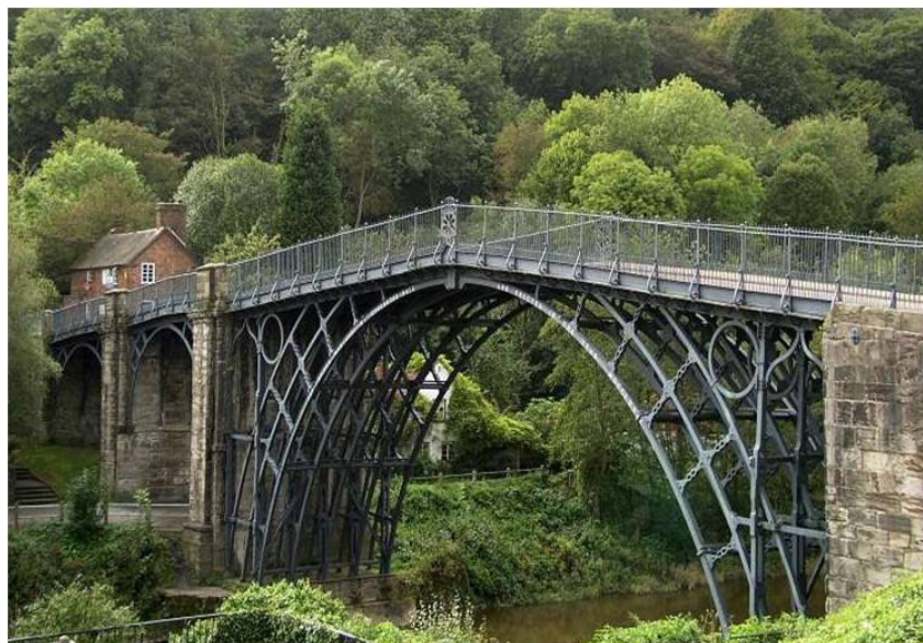
[Fig. 8] Vista da Ponte de Coalbrookdale, rio Severn George (1777-81). Projeto do arquiteto Thomas Pritchard e do fundidor Abraham Darby III.
