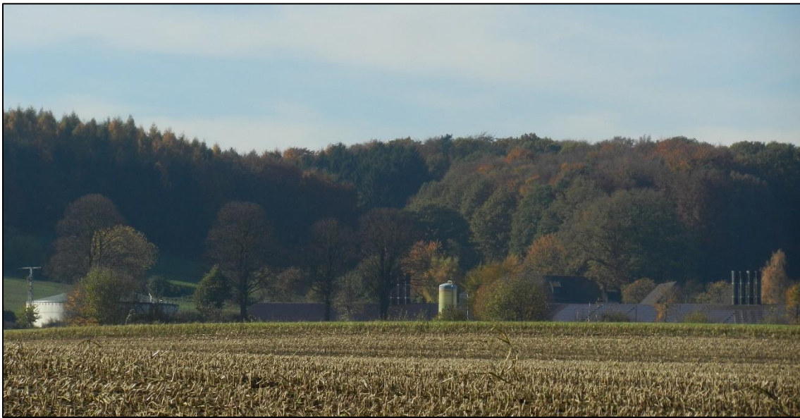
Abbildung 15: Biogasanlage im nördlichen Teil des Landkreises Osnabrück (Foto: E. Milz)
