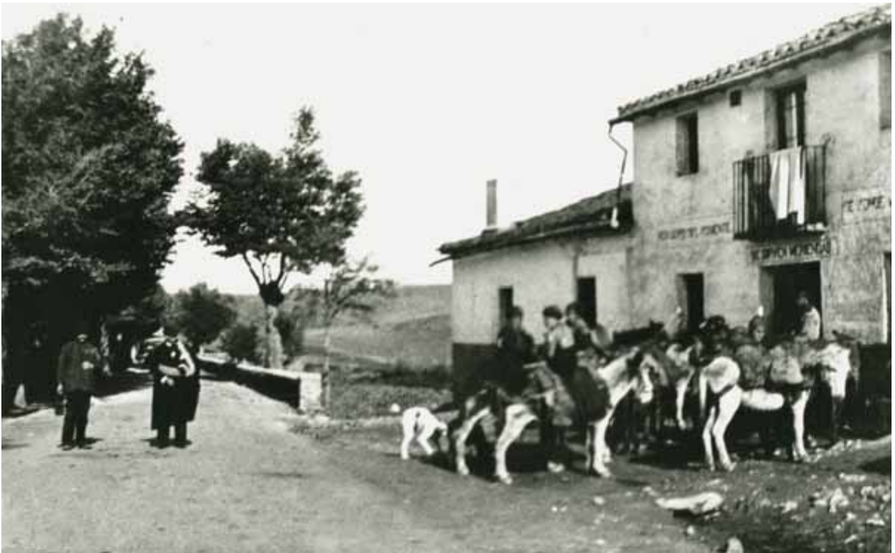
Carretera de Madrid en el puente de Golmayo, a la derecha, Ventorrillo del Mediodía, 1890-1900. Foto de Juan José García García. Archivo Pilar García de Diego (AHP SO).
