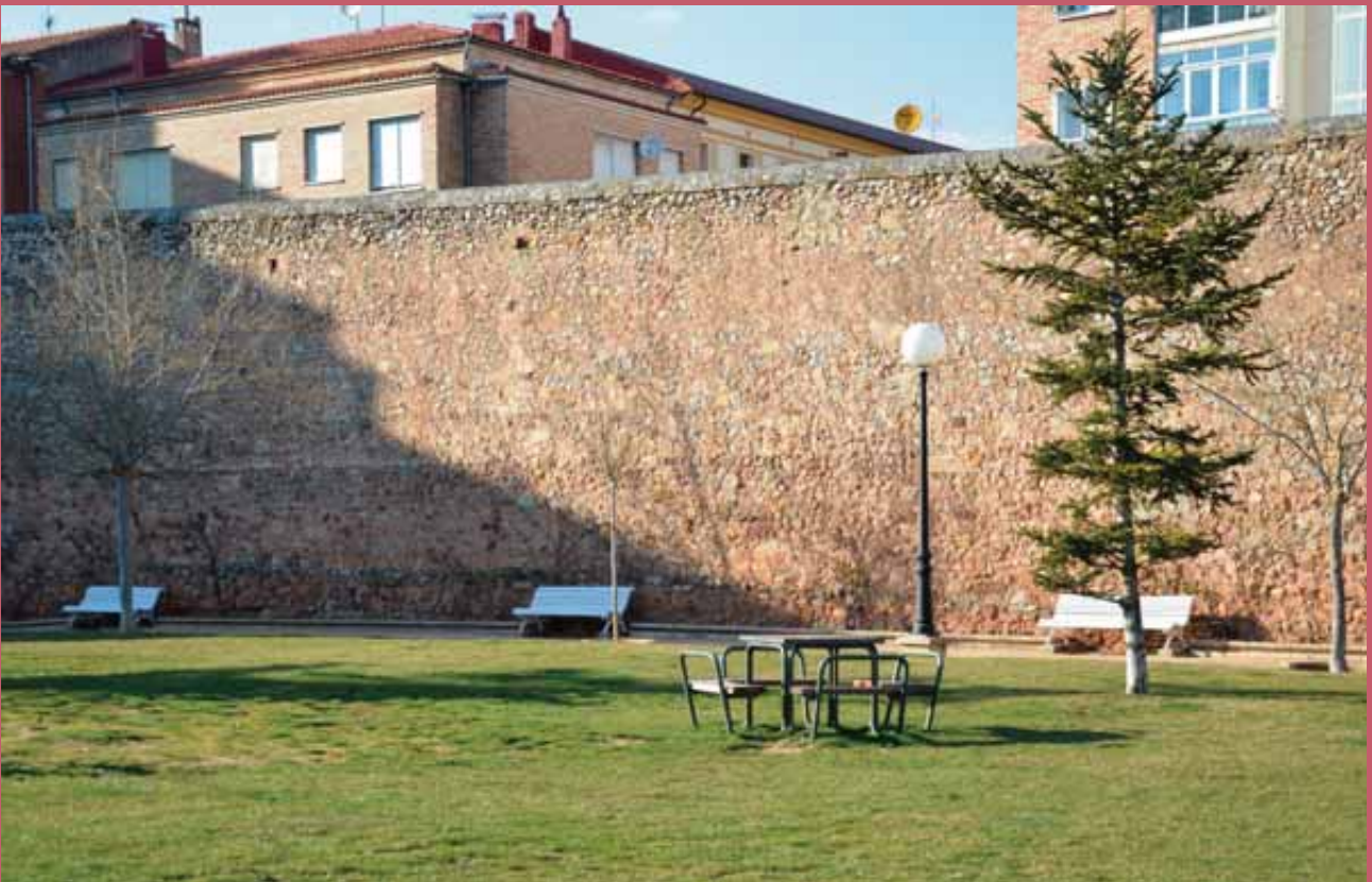
Tramo de la muralla en el parque de Santa Clara. Foto JFP, 2014.
