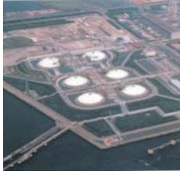
LNG storage tanks
