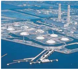
LNG storage tanks
