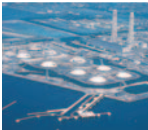
LNG storage tanks
