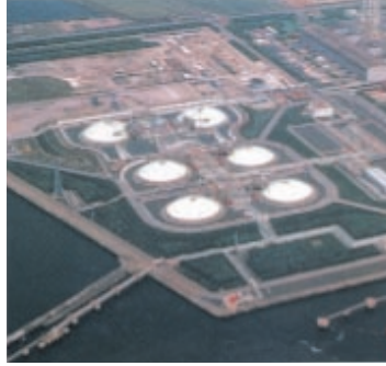
LNG storage tanks
