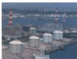
Japan's first LNG tanks
