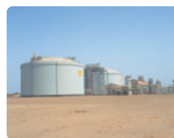
LNG terminal for India's Petronet LNG Ltd. (PLL)
