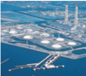
LNG storage tanks
