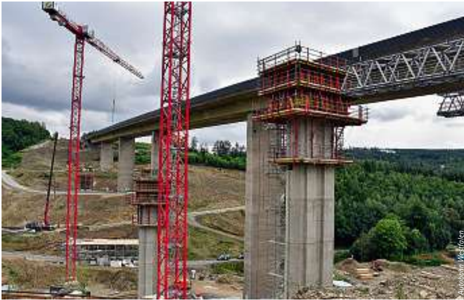
Der Bau des ersten Teilstücks der Talbrücke Eisern ist in vollem Gange. Diese Arbeiten werden im Oktober 2022 abgeschlossen. Dann wird das zweite Teilbauwerk gesprengt.
