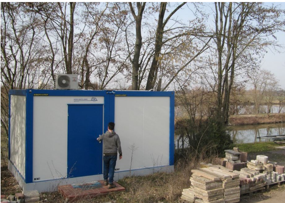
Photo 2 : station d'analyse de Kahl am Main (Wasserwirtschaftsamt Aschaffenburg), Bavière
