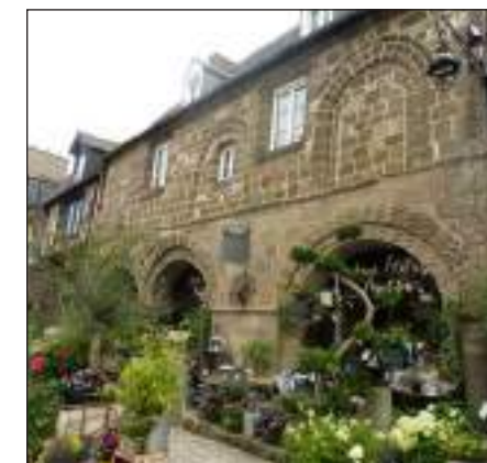
Fig. 235 : Maison des Petits Palets, 17 Grande Rue des Stuarts
