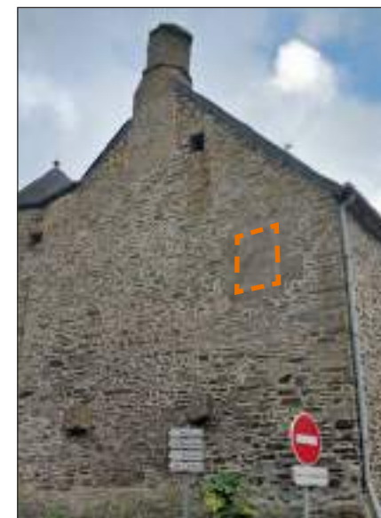
Fig. 201 : Baie murée, faubourg de l'Abbaye-sous-Dol
