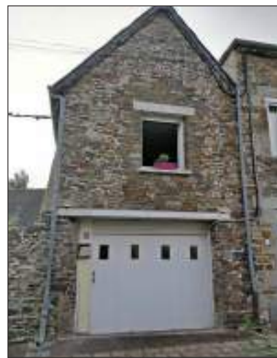
Fig. 189 : Pignons sur rue, Passage des Bas-Celliers
