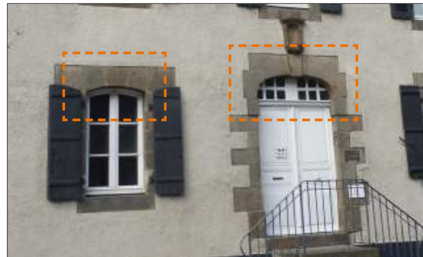
Fig. 199 : Arc surbaissé à gauche et arc en anse de panier à droite, Rue Yves Estève
