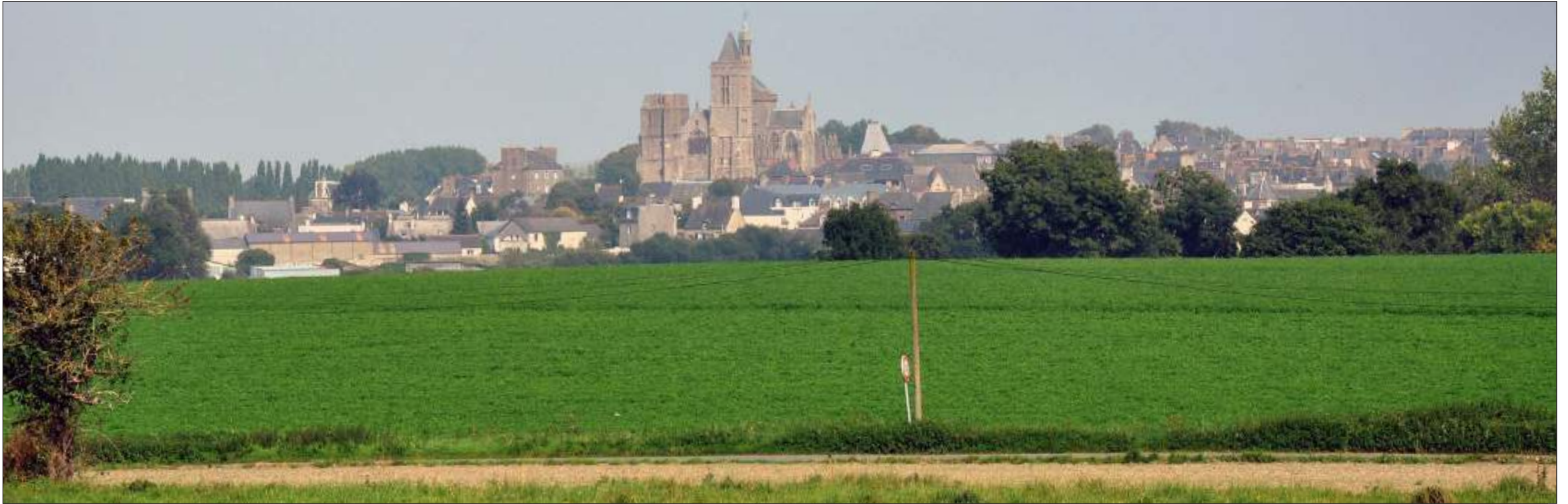
Fig. 412: Vue sur la Cathédrale depuis l'ouest
