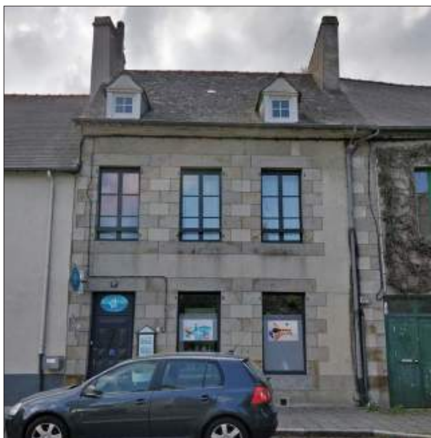
Fig. 215: 57 Rue de Saint-Malo
