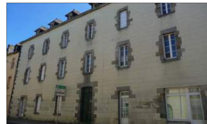
Fig. 263 : Ancien Hôtel-Dieu rue des Ponts
