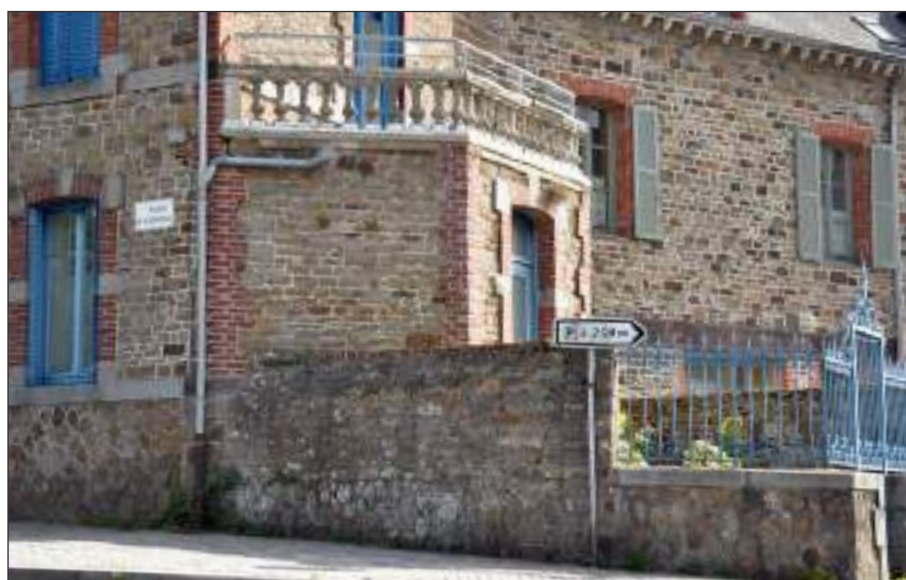
Fig. 94 : Mur plein et mur bahut square Nominoë
