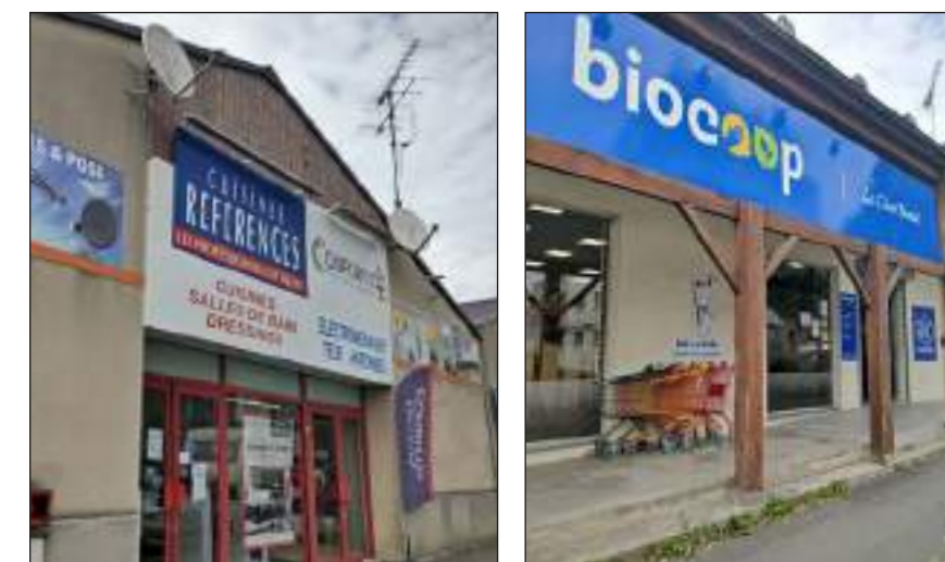
Fig. 316 : Entrepôts, 13 boulevard Deminiac
