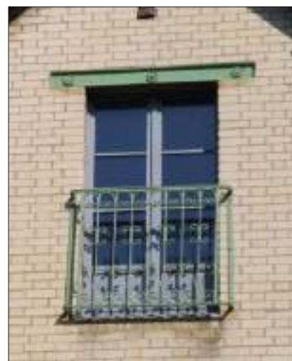
Fig. 359 : Garde-corps en fer forgé, 2 Grande-Rue des Stuarts
