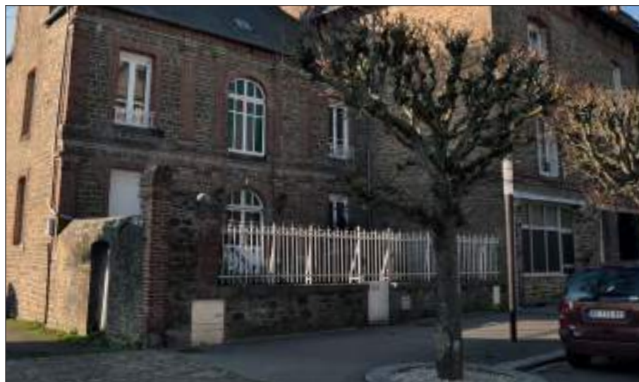
Fig. 95 : Mur plein et mur bahut Bd Planson
