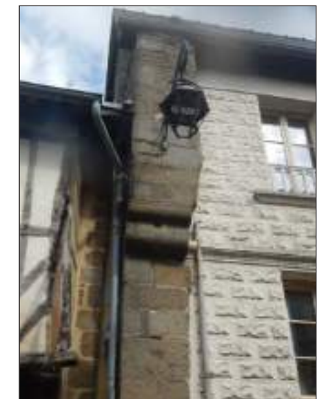
Fig. 207 : Mur refend d'un pan de bois disparu, rue Ceinte
