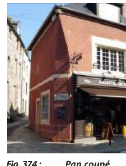
Fig. 374 : Pan coupé permettant le passage des charrois
