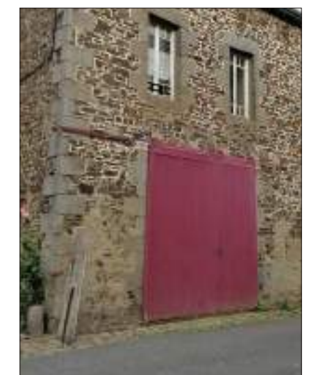
Fig. 388 : Reprises en enduit hydraulique (ciment...)
