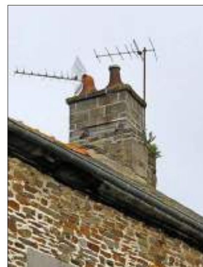
Fig. 369 : Souche en moellons rehaussée en parpaings
