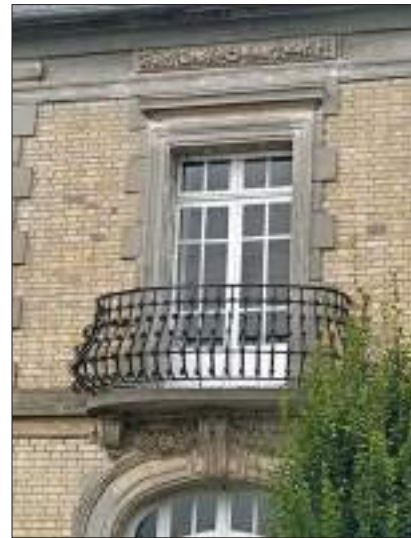
Fig. 344 : Garde-corps en fer forgé, 21 boulevard Deminiac
