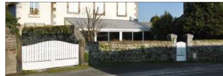
Fig. 97 : Muret rue de Paris
