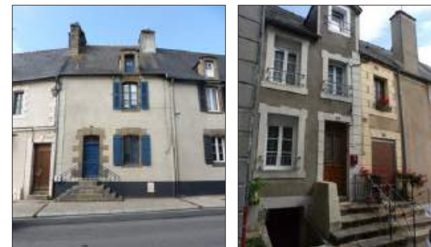
Fig. 271 : 3 rue Yves Estève Fig. 272 : 6 rue des Perrons
