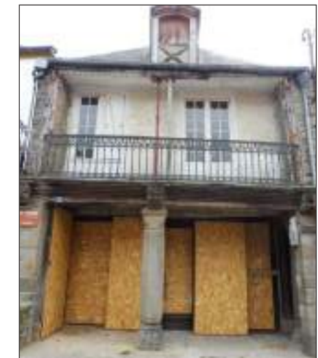
Fig. 205 : Galerie couverte interrompue, Grande Rue des Starts
