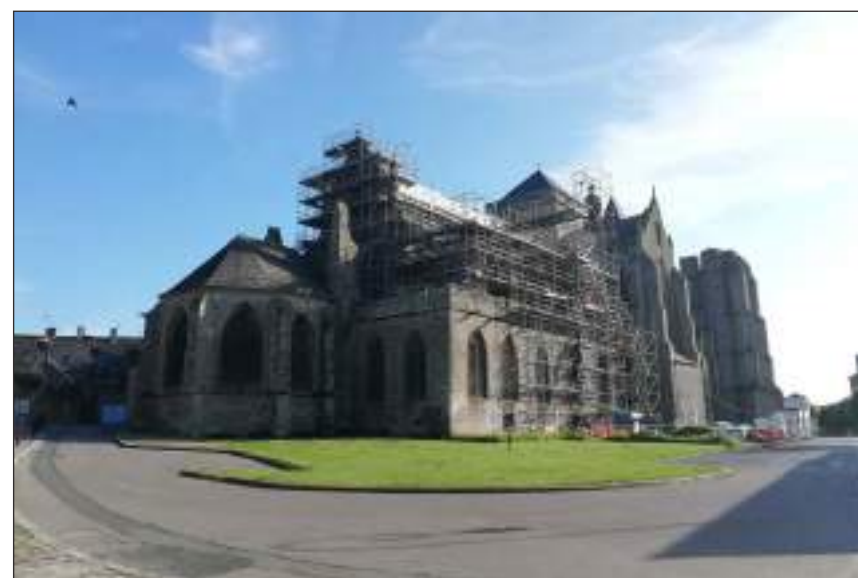
Fig. 408 : Des travaux d'entretien de la cathédrale de Dol-de-Bretagne
