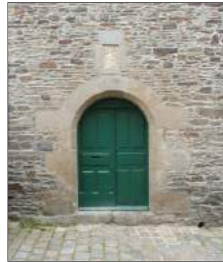
Fig. 197 : Arc plein cintre, Rue Ceinte
