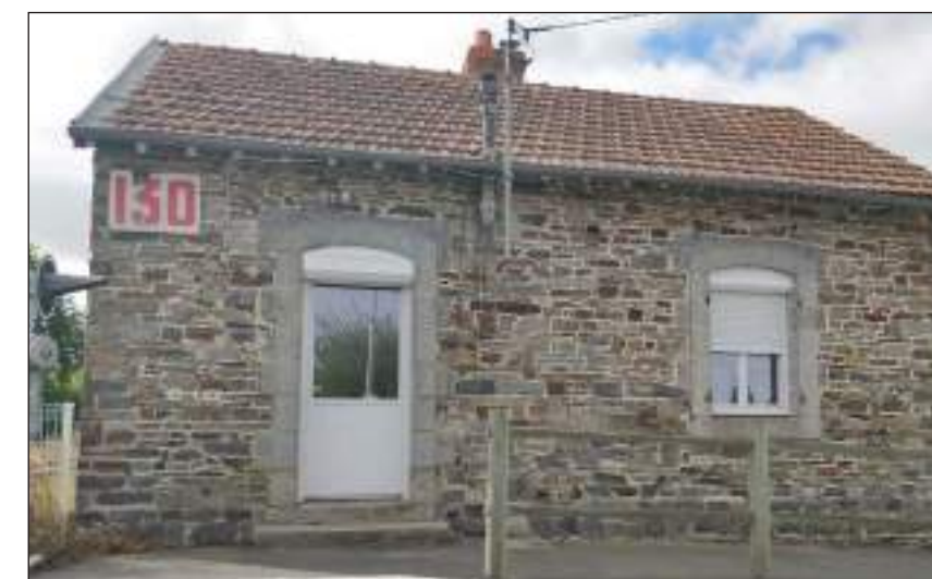
Fig. 143 : Maison de garde-barrière, Rue Pasteur
