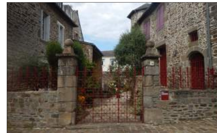
Fig. 230 : Manoir du Grand Chantre, rue Ceinte
