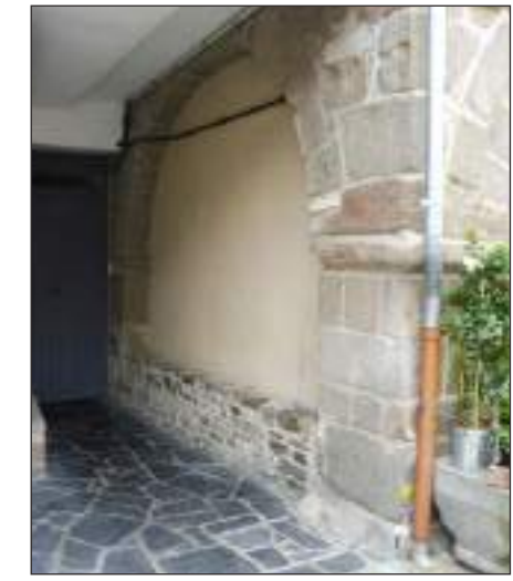
Fig. 203 : Galerie de porche murée, Grande Rue des Stuarts
