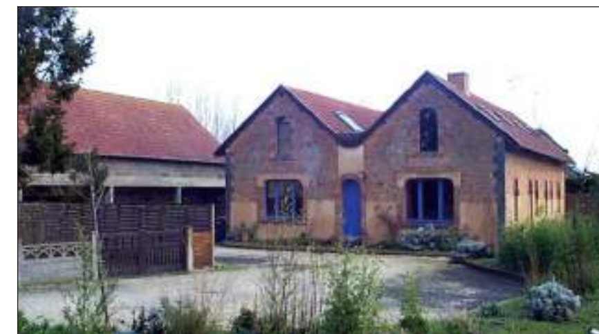
Fig. 140 : Briqueterie, 8 passage de la Lavanderie, le Pont Labbat (©Inventaire)
