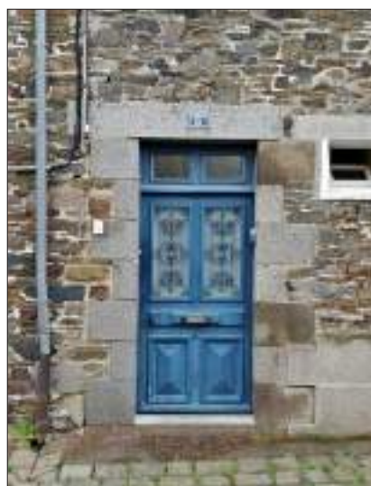
Fig. 324 : Porte/encadrement pierre de taille/linteau droit
