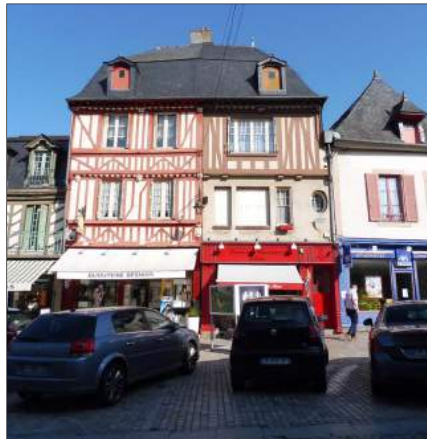
Fig. 210 : Le Grand Croissant, 8 Gd Rue des Stuarts
