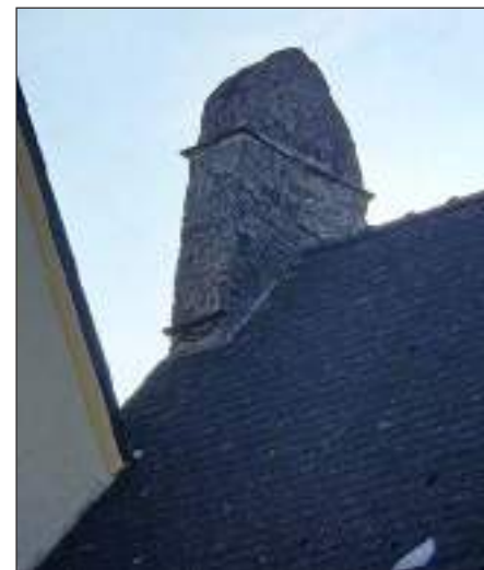
Fig. 195 : Souche de cheminée ancienne, faubourg de la Chaussée
