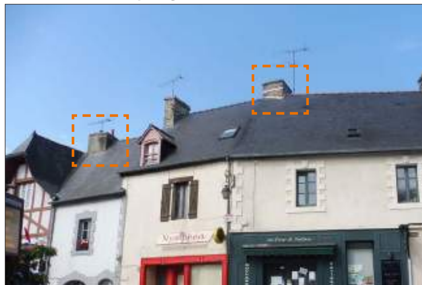
Fig. 196 : Souches de cheminées anciennes, rue Yves Estève
