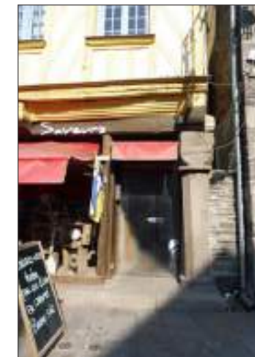
Fig. 204 : Galerie couverte interrompue, Rue Lejampel
