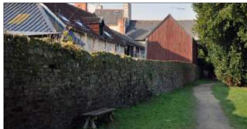
Fig. 88 : Mur haut en limite séparative
