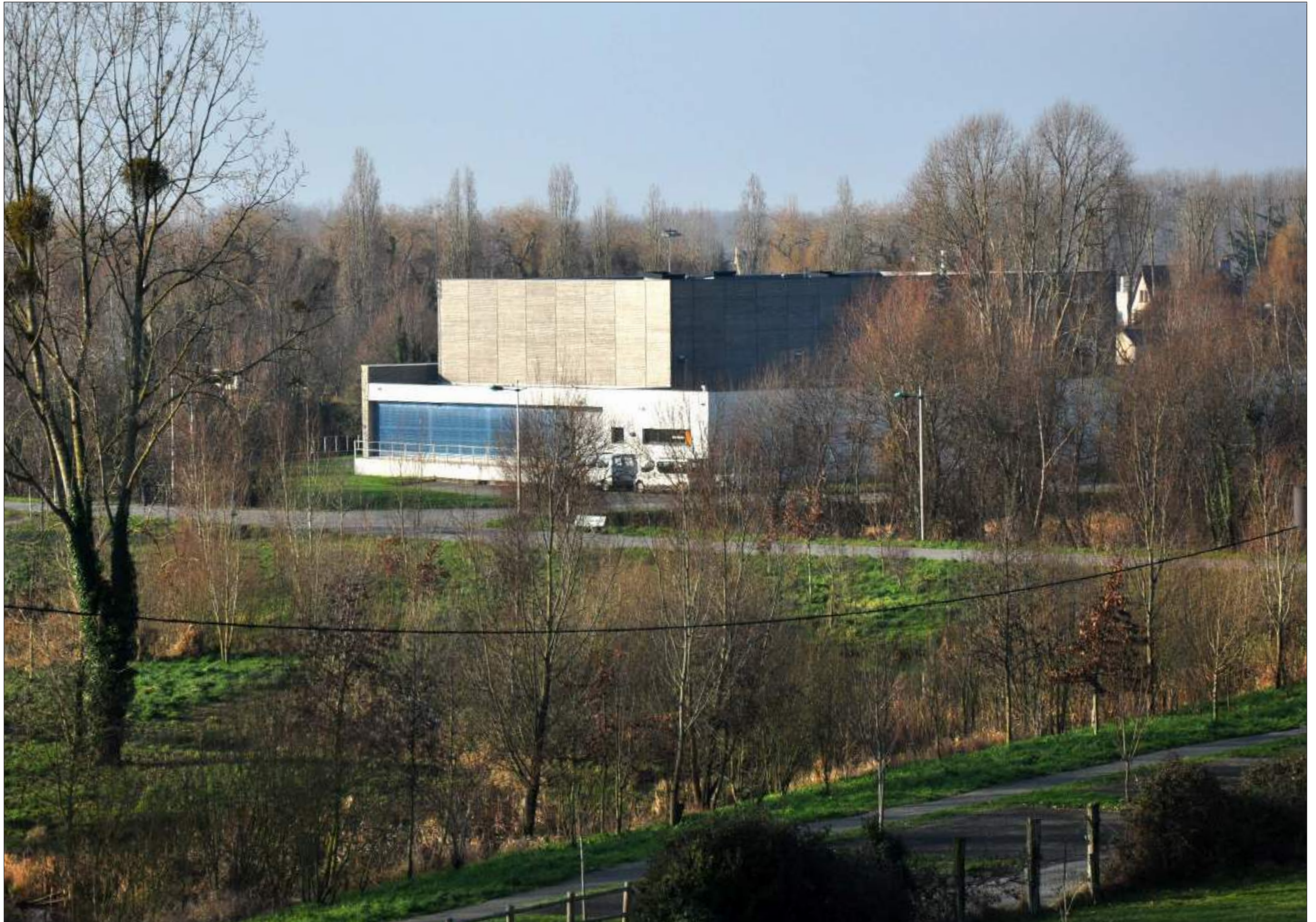
Fig. 158 : Centre culturel L'Odysée - Façade sud sur la vallée du Guyoult
