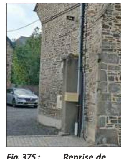
Fig. 375 : Reprise de pan coupé permettant le passage des charrois
