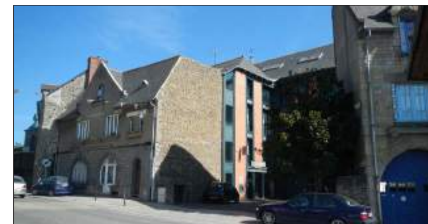
Fig. 312 : Bureaux, 19 et 2 rue Yves Estève
