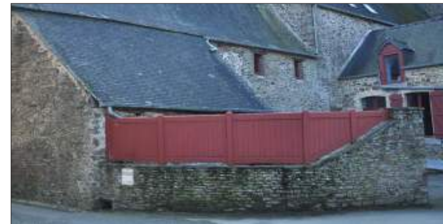
Fig. 98 : Muret rue de Paris
