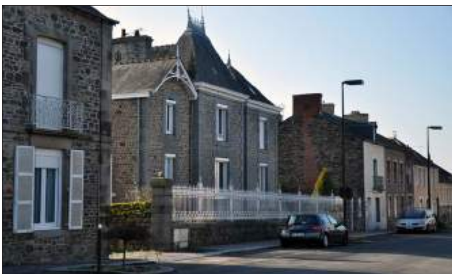
Fig. 91 : Mur bahut rue de Rennes
