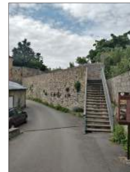
Fig. 117 : Remparts sud, accès vers le passage des Bas Celliers
