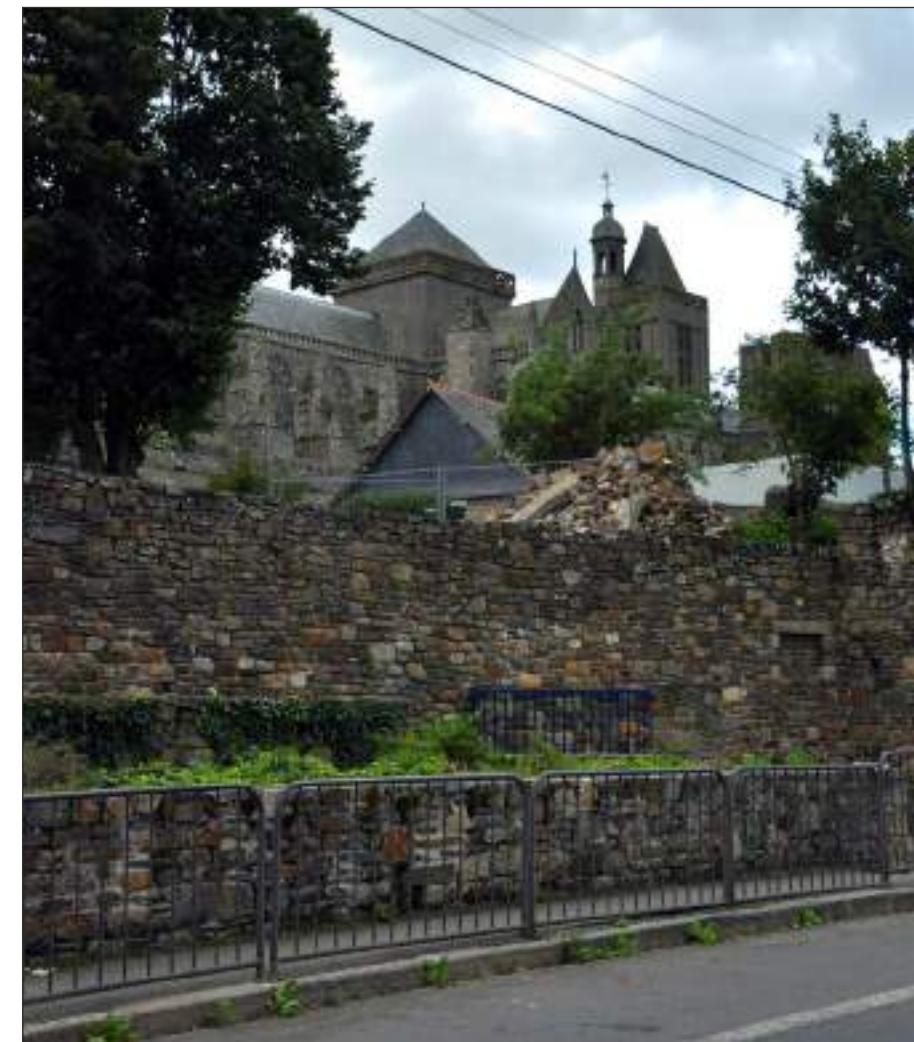
Fig. 92 : Mur de soutènement rue des Murets
