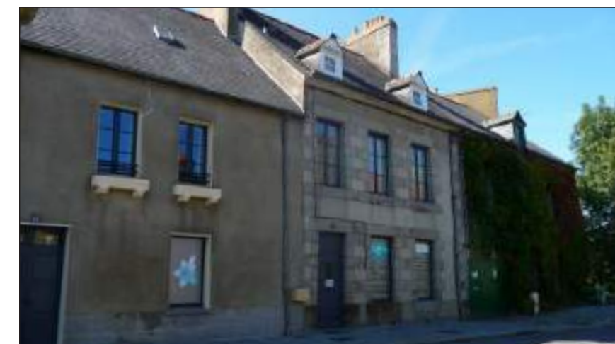
Fig. 294 : Maisons, 53-57-59 rue de Saint-Malo
