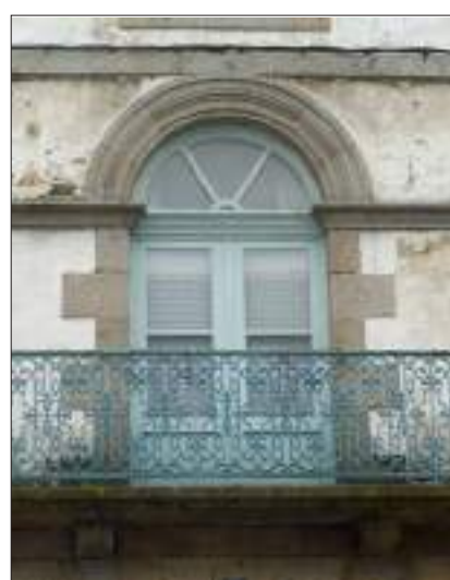
Fig. 330 : Arc plein cintre
