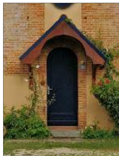
Fig. 325 : Porte/encadrement brique/arc plein cintre
