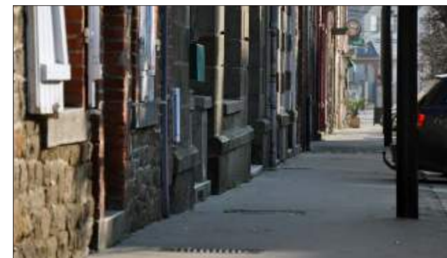
Fig. 84 : Façades à l'alignement Bd Planson
