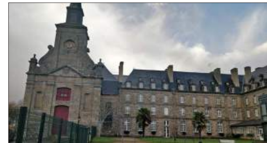
Fig. 262 : Ancien grand séminaire de l'Abbaye-sous-Dol devenu maison de retraite
