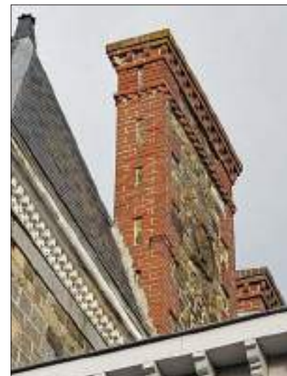
Fig. 366 : Souche en briques et moellons avec motif
