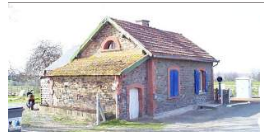
Fig. 144 : Maison de garde-barrière, Le Chêne
