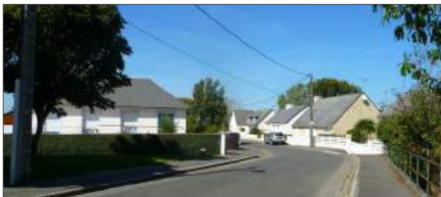
Fig. 147 : Quartier pavillonnaire des Ylouses
