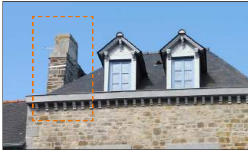
Fig. 193 : Souche de cheminée rehaussée, place Toullier
