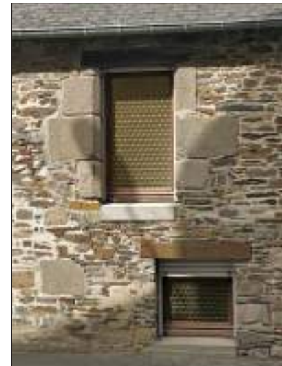
Fig. 381 : Baie redimensionnée et désaxée
