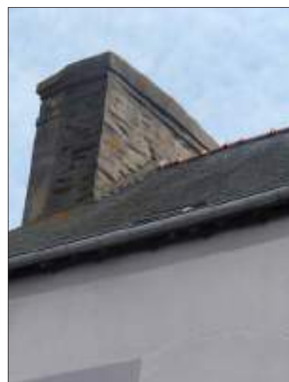
Fig. 368 : Souche en moellons en partie enduite
