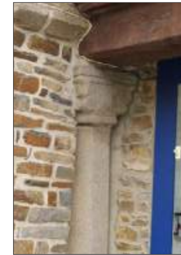
Fig. 202 : Pilier noyé dans la maçonnerie, Grande Rue des Starts
