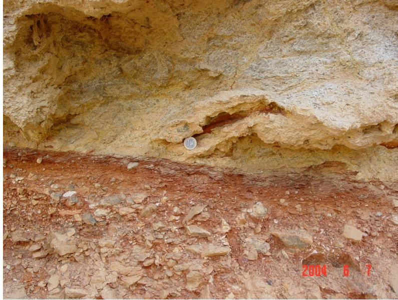
Figura 19. Detalle del contacto entre los materiales cámbricos (dolomía Ribota) y los materiales del Terciario. Pueden apreciarse los diques intrusivos de materiales terciarios (arcillas rojizas) dentro de los materiales cámbricos. También puede observarse una tendencia a la alineación paralela al plano de contacto de los cantos y bloques de los materiales del Terciario cercanos a dicho plano.
