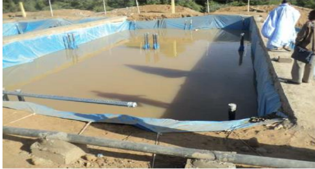
Figure II.23. Bassins de l'éclosérie du barrage de Foum Legleita
