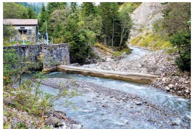
Abb. 22 Liechtensteiner Auslaufbauwerk an der Samina.
