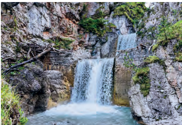
Abb. 21 Die Talsperre im Falleck ist für Fische unüberwind- bar. Eine geplante Fischtreppe wurde nicht realisiert.
