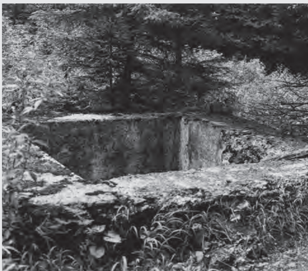
Abb. 16 Die alten Fundamente der Seilbahn
