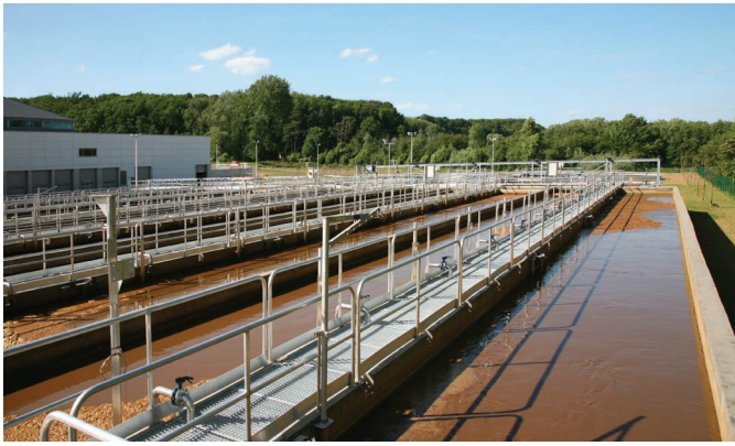
L'ancienne ligne de traitement biologique rénovée
