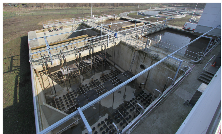
La nouvelle ligne de traitement biologique
