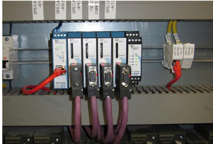
Bei der Georgsmarienhütte sind verschiedene Kombinationen der INBLOX-Module im Einsatz. Das linke Bild zeigt den E-Kopf sowie ein DP Diag+ Rep-Modul und das Alarmmodul. Im rechten Bild ist die maximale Ausbaustufe mit einem E-Kopf, vier DP Diag+ Rep-Modulen und einem Alarmmodul erreicht.
