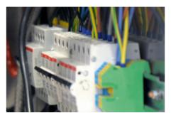
Befestigen und Verdrahtung der Hutschiene mit den Sicherungsautomaten. Diese Automaten bitte spritzwassergeschützt und zugriffsicher unterbringen. Sie müssen aber zugänglich bleiben, um im Falle eines Auslösens vom Gerätebetreiber wieder eingeschaltet werden zu können. Sie stellen eine zusätzliche Sicherung des Systems dar.
