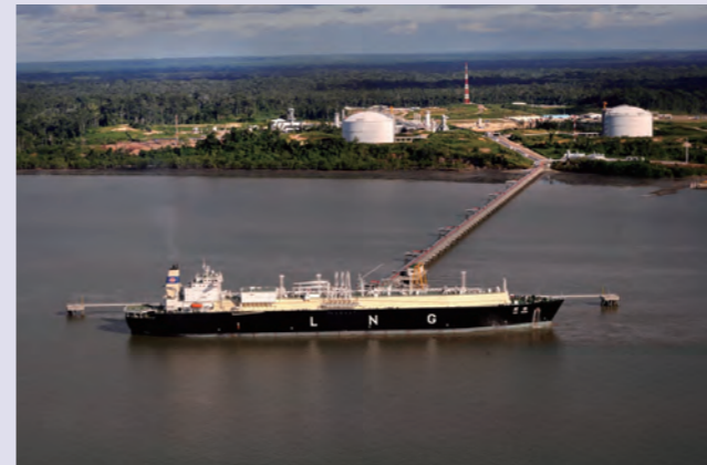
Unloading berth at Tangguh LNG Terminal
