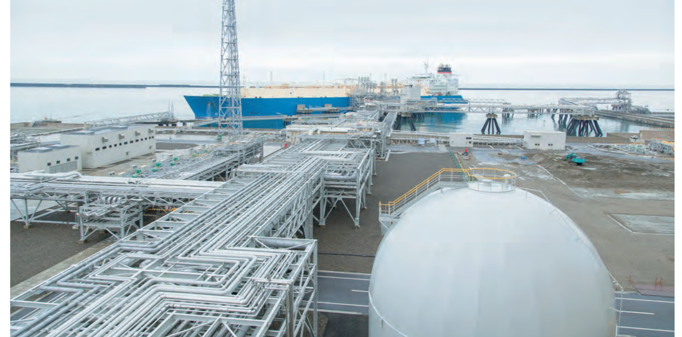
LNG carrier arriving at the completed Naoetsu LNG Terminal
