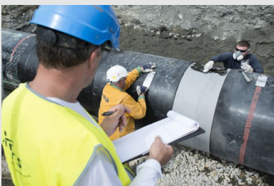
© Grégoire Maisonneuve pour l'INRS - 2017 Utilisation de résines époxy lors de la construction d'un gazoduc
