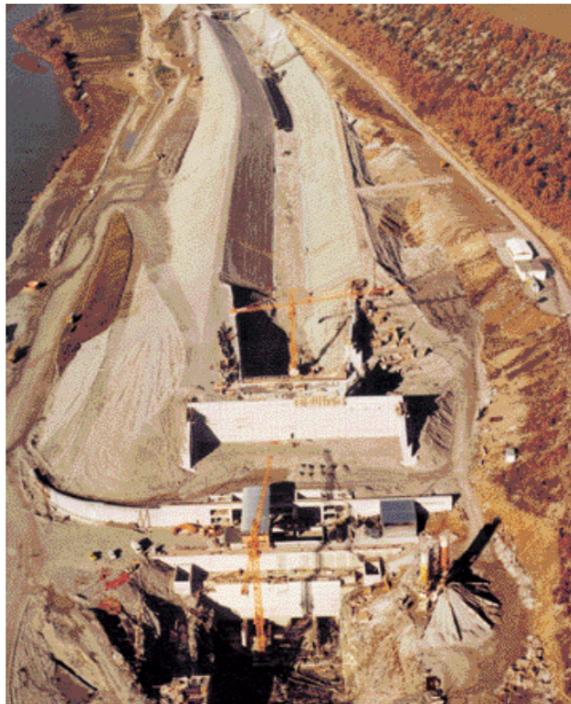
Aménagement de Salignac (1973-1974) : vue aérienne du canal d'amenée en février 1976. Ce grand barrage mobile sur la Durance mesure 77 mètres de large et 28 mètres de haut au-dessus des fondations
