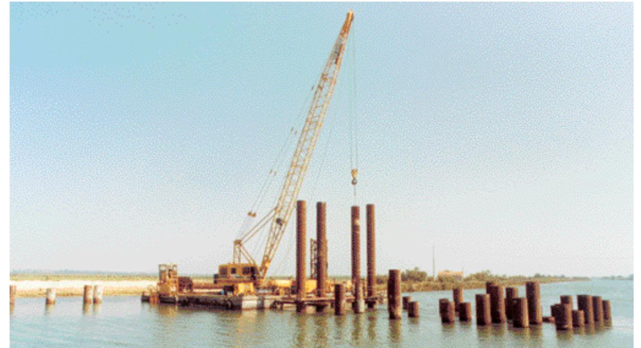
Barrage anti-sel de Fleury d'Aude achevé. Tenant compte de la très faible portance du substratum vaseux, l'ouvrage est fondé sur 91 pieux métalliques de 1,07 mètre de diamètre, qui ont pour fonction de porter le barrage au-dessus des vases
