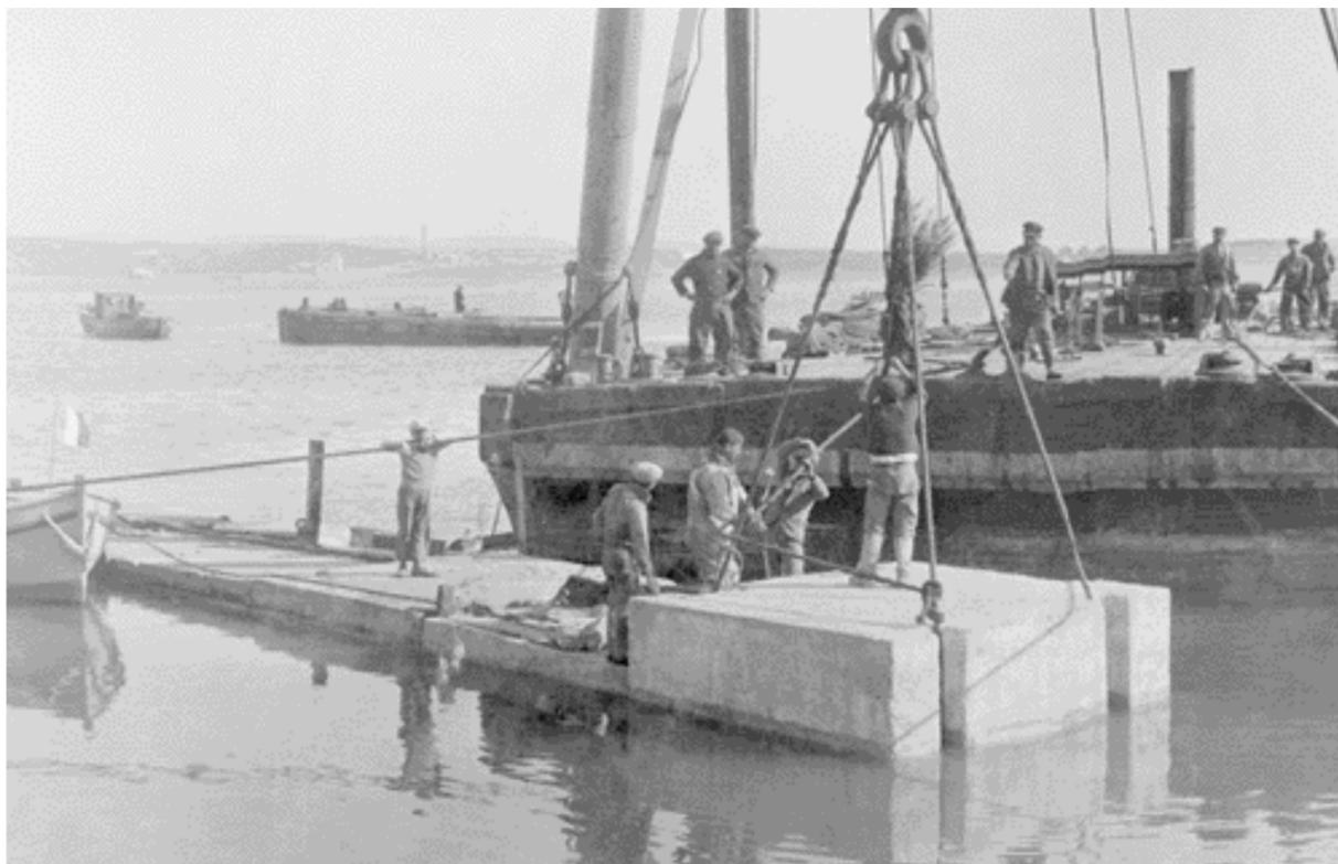
Port de Marseille : mise en place du dernier bloc de béton au quai de la Légue (septembre 1931)
