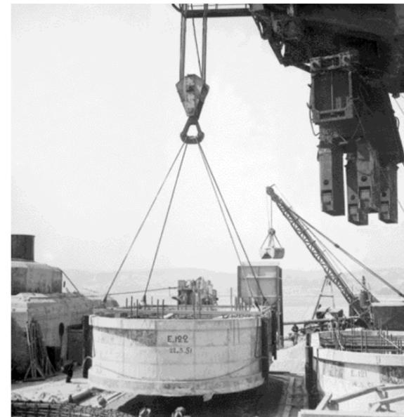
Port pétrolier de Lavéra (16 avril 1951) : levage d'une embase à deux colonnes par la "Samsonne" munie d'un crochet de 200 tonnes (ci-dessus et ci-contre)
