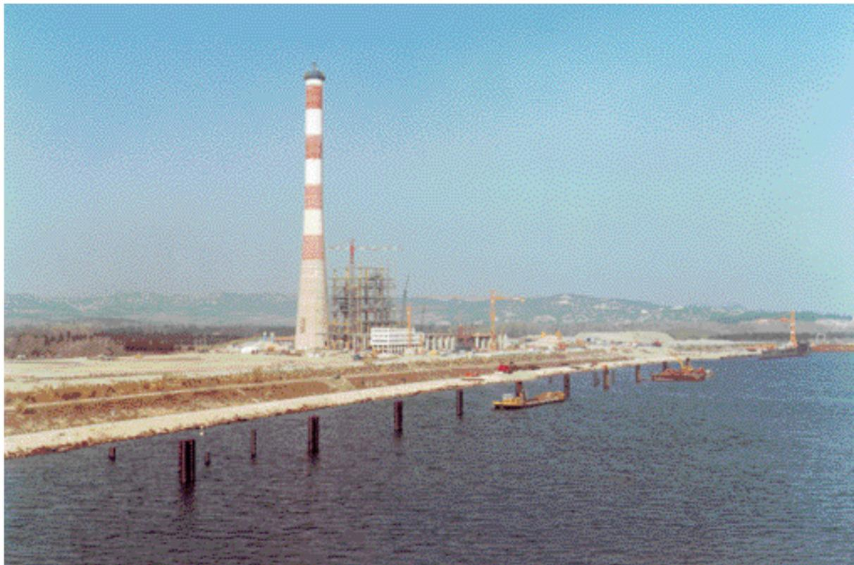
Centrale thermique d'Aramon (1974-1977) : cheminée achevée, le 24 février 1975. La cheminée de 250 mètres de hauteur est constituée d'un tronc conique à sa base, puis cylindrique dans son élévation, dont le fût est construit en béton
