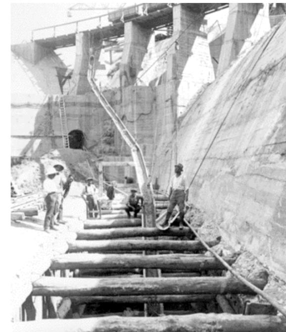
Barrage du Ghrib : bétonnage du contrefort de la galerie rive gauche (juillet 1931)
