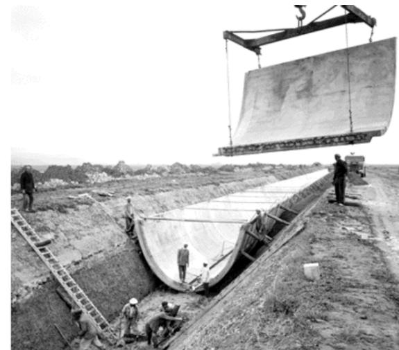
Irrigation des plaines du Cheliff : pose des canalisations en provenance de l'usine d'Inkermann
