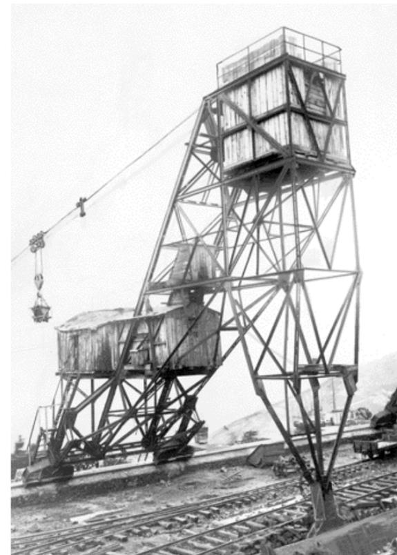
Barrage d'Éguzon : pylônes pendulaires des télécharges, le 27 mars 1925
