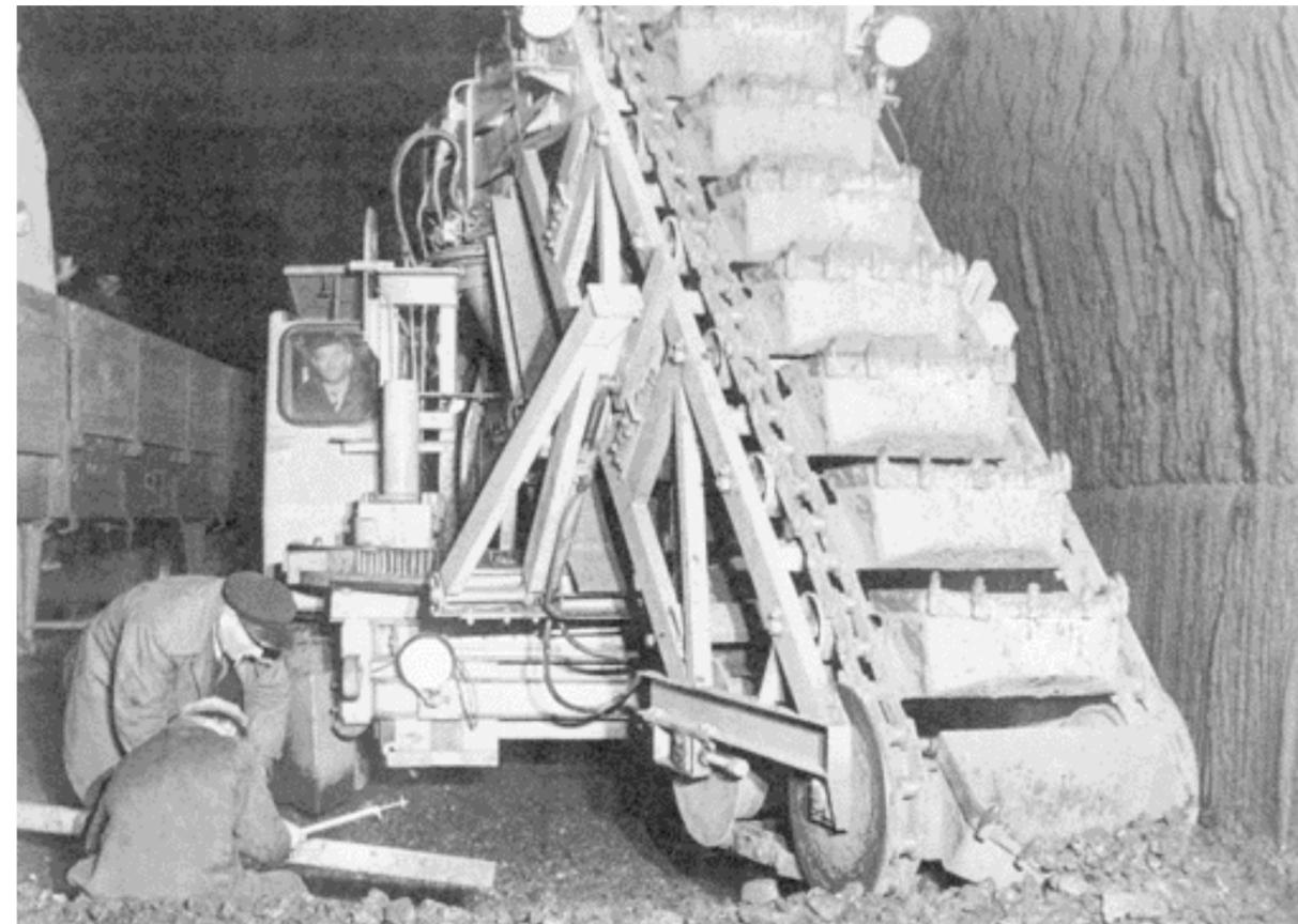
Desquenne et Giral : la dégarnisseuse sur chenille, utilisée lors des travaux d'abaissement sur la ligne Paris-Le Havre, témoigne de la capacité d'innovation de l'entreprise (années 1950)
