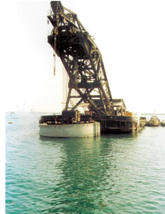
Extension du port de Sète (1979-1981) : transport par la "Samsonne" d'une colonne préfabriquée
