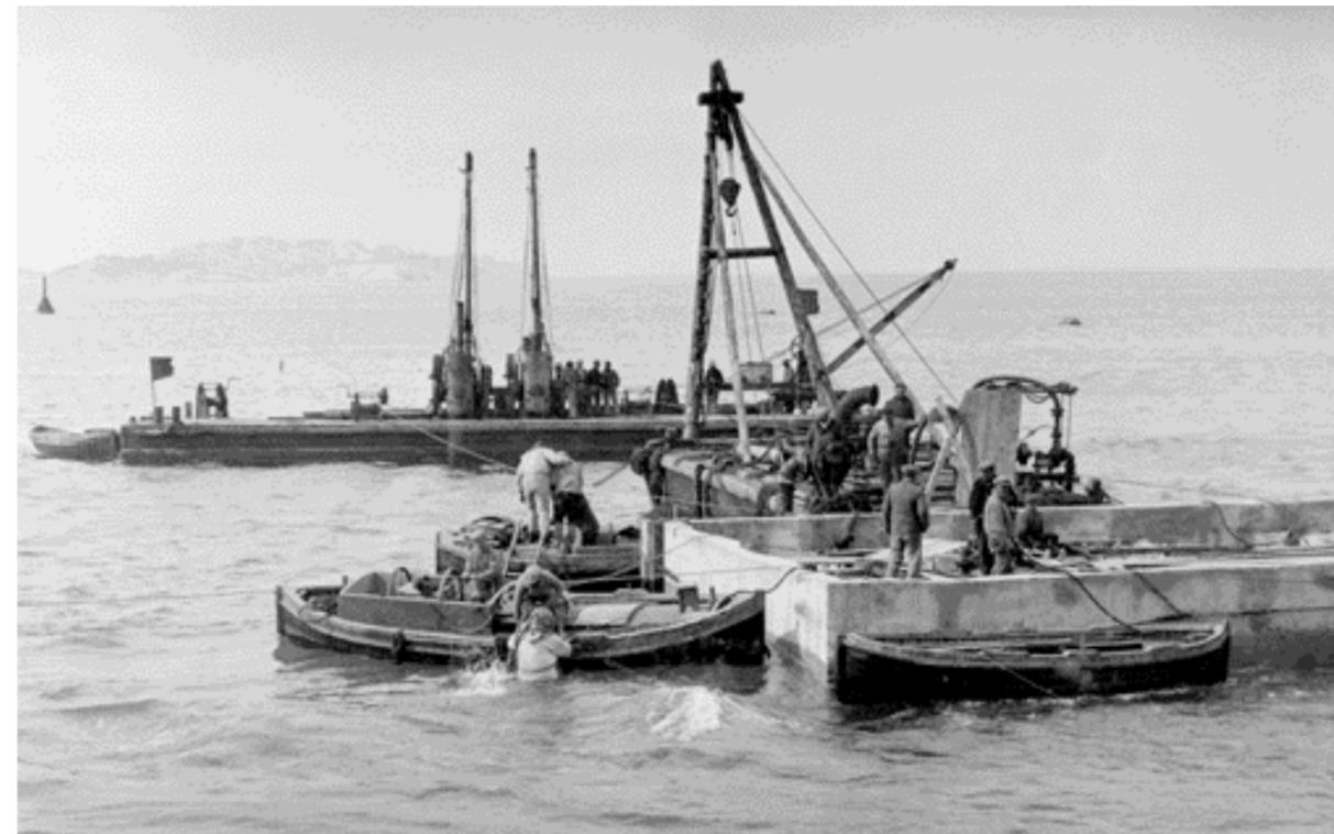
Le bassin de la Joliette à Marseille en construction : mise en place de blocs de béton de 16 mètres cubes (16 janvier 1930)
