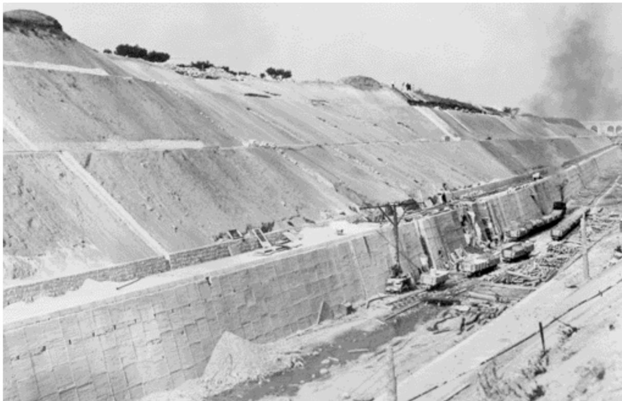
Construction des derniers éperons de renforcement des murs de tranchée à l'éboulement du talus Ouest en 1926
