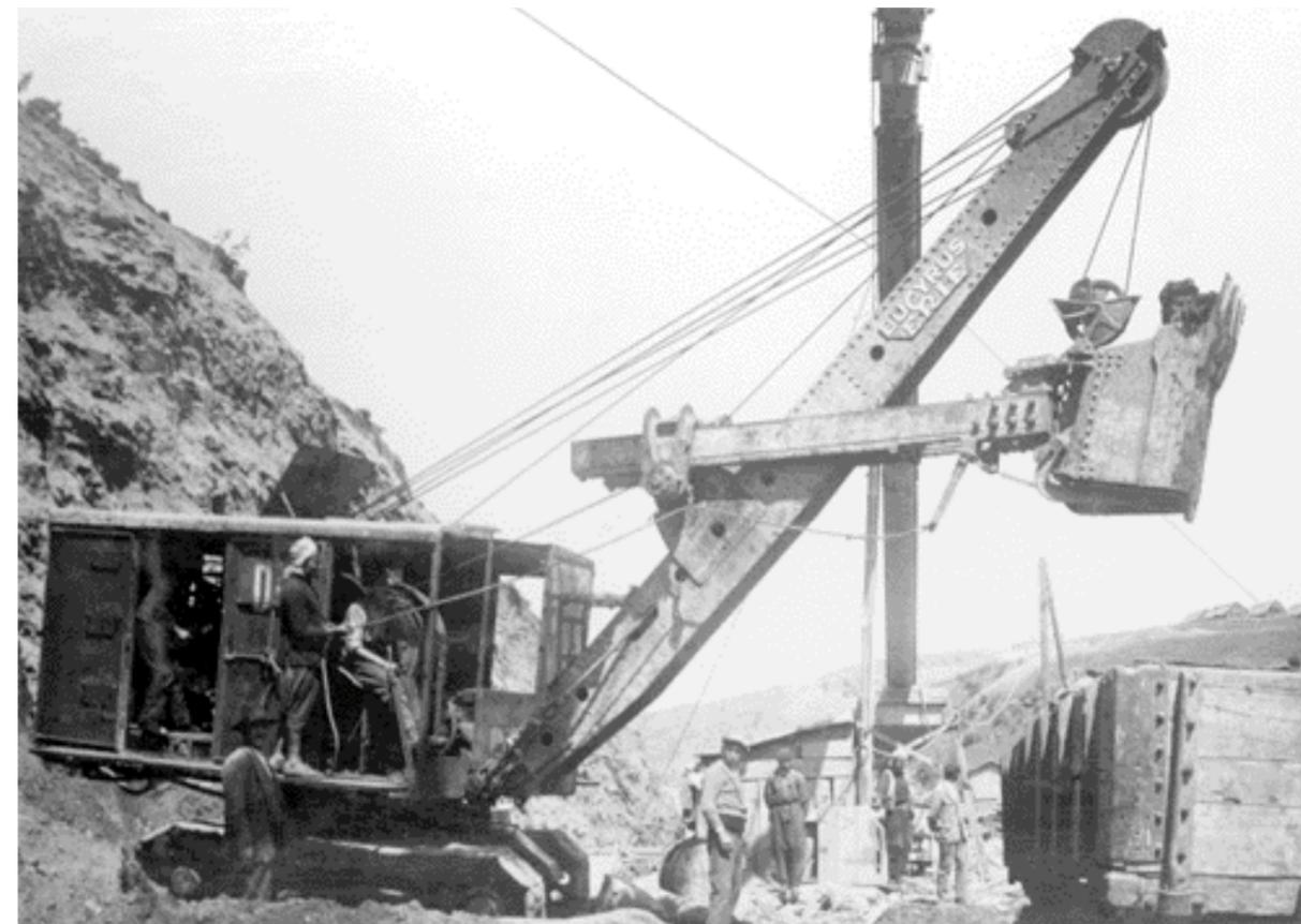
*Barrage du Ghrib : une pelle 50 B Bucyrus en action sur le chantier du déversoir.
