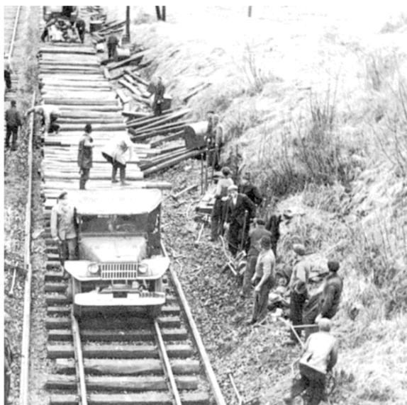
Desquenne et Giral : les fameuses Dodge 4x4 rail-route, adaptées par Albert Giral, sont utilisées sur de nombreux chantiers de renouvellement de voies ferrées (années 1950)
