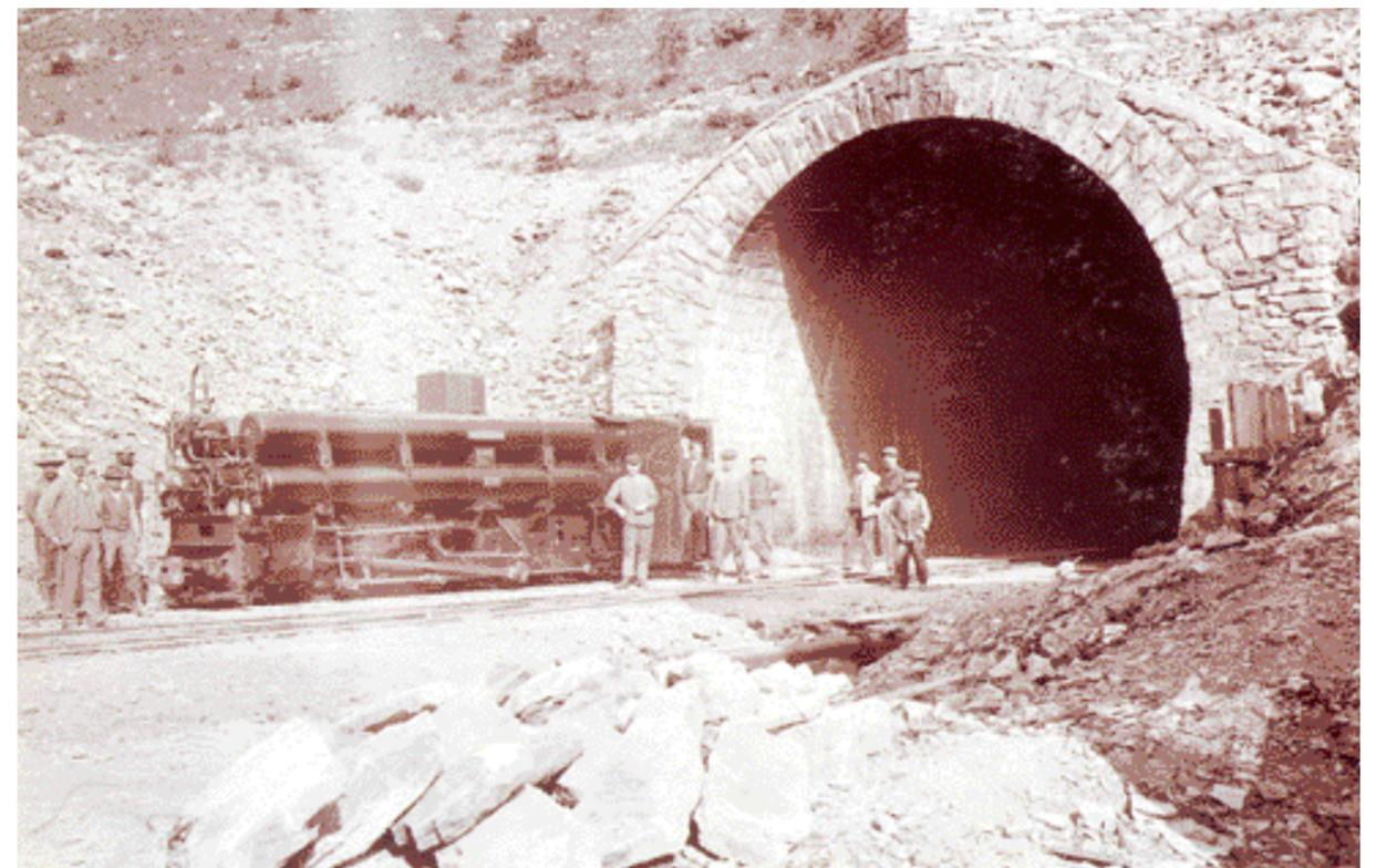
*La machine à air comprimé à l'entrée du tunnel (1910)*
