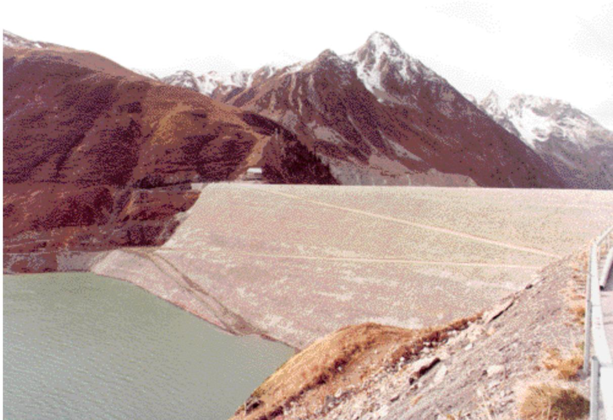
*Barrage de Grand'Maison : parement amont (9 novembre 1984). De l'ordre de grandeur de ceux du barrage de Serre-Ponçon, les travaux gigantesques de Grand'Maison consistent à mettre en place un barrage en terre et enrochement de 12,5 millions de mètres cubes de matériaux, d'une hauteur de 160 mètres au-dessus des fondations et de 550 mètres de longueur en crête*
