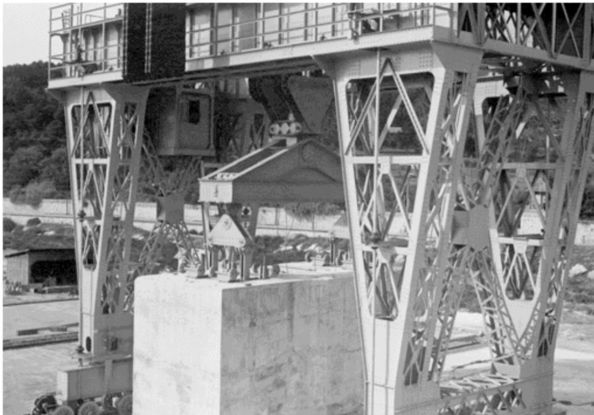
Port de Marseille, prolongement de la digue du Large : un bardeur de bloc en ciment de 450 tonnes, soulevé le 5 août 1932 après 32 jours de séchage
