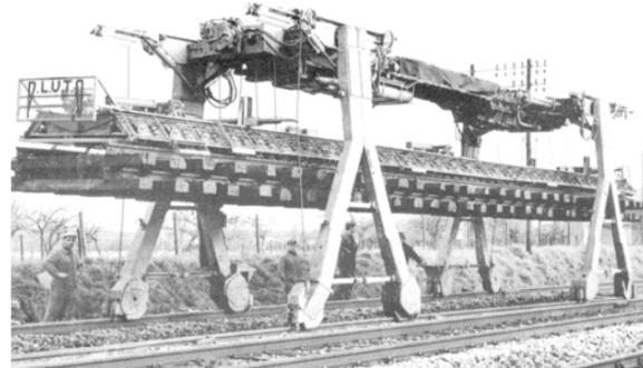
*"Pluto", un portique de pose de voies ferrées original inventé par Albert Giral (fin des années 1960)*
