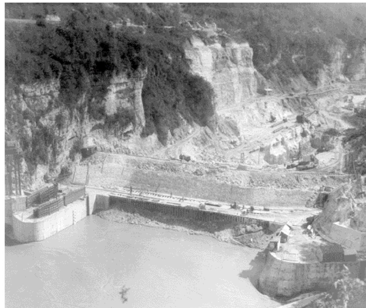
Reprise des travaux au barrage de Génissiat : réalisation du prébardeau amont qui avait été détruit par la submersion
