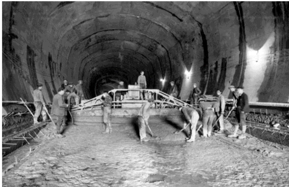
Barrage de Génissiat : exécution du radier à la machine "Ord" dans le souterrain de dérivation rive droite (5 avril 1939)
