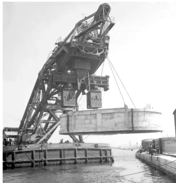
Port pétrolier de Lavéra (16 avril 1951) : mise à l'eau d'une embase à deux colonnes (ci-dessus et ci-contre)
