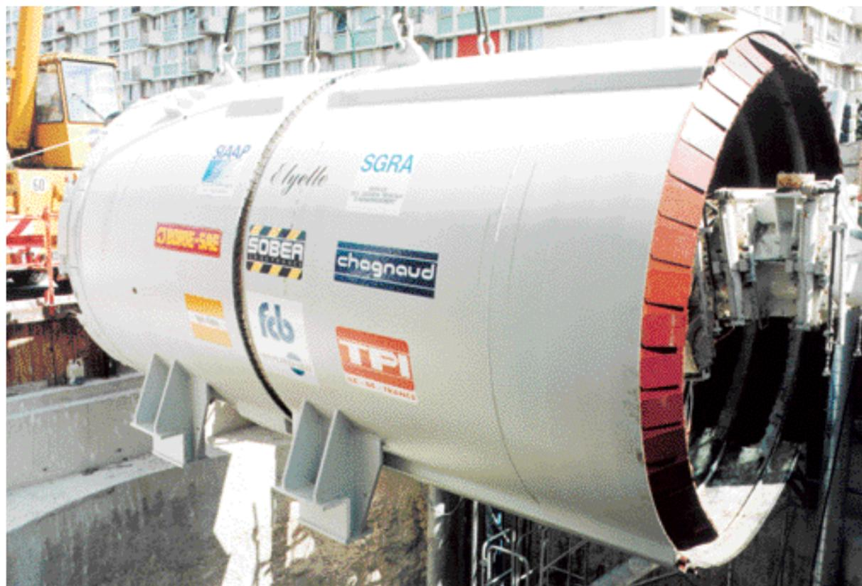
Le tunnelier à pression de boue Eylette en préparation au collecteur souterrain qui relie l'usine de prétraitement de Clichy à celle de la Briche à Épinay-sur-Seine (lot 3). Depuis un siècle et l'époque de Léon Chagnaud, la technologie des tunneliers a réalisé des progrès décisifs. Là, il s'agit de construire un émissaire de 17 kilomètres de long
