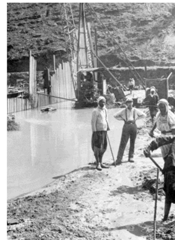
Barrage du Ghrib : mise en place de l'enceinte en palplanches (25 mai 1929). L'entreprise embauche d'abord une main-d'œuvre locale, puis décide de mécaniser le chantier
