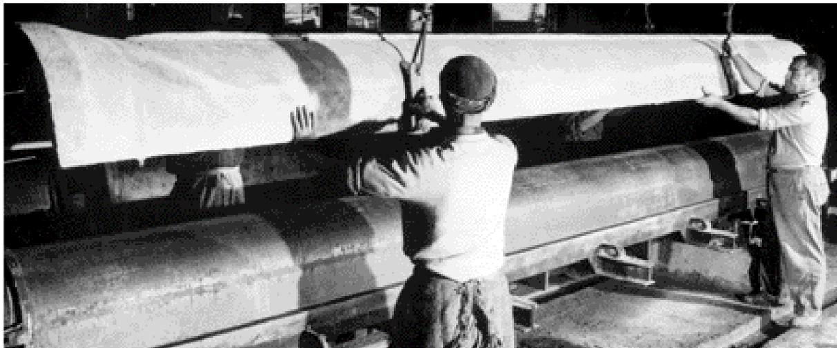
Usine d'Inkermann : décoffrage d'un élément de canalisation préfabriqué (1948). La politique salariale de Maurice Cochard, rémunérant bien au-dessus de la moyenne algérienne, permet une forte stabilité de la main-d'œuvre autochtone
