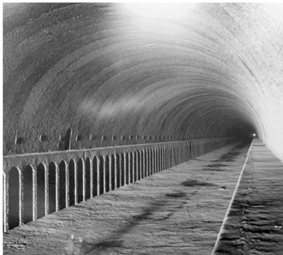
*Le souterrain du Rove entièrement achevé juste avant sa mise en eau ; des dimensions exceptionnelles avec 22 mètres de large et 15,4 mètres de haut*
