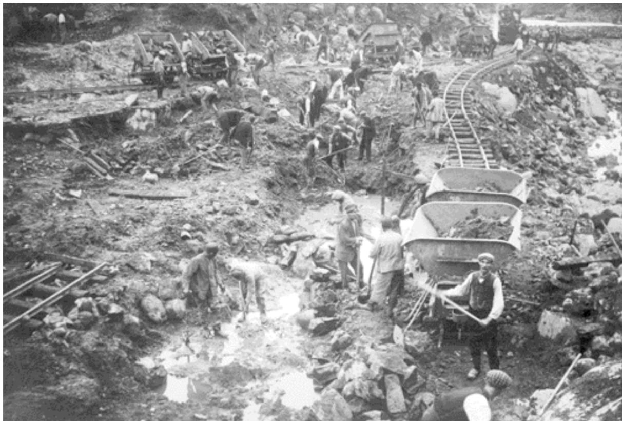
Barrage d'Éguzon : la mise en place du batardeau de protection de l'usine, le 3 octobre 1922
