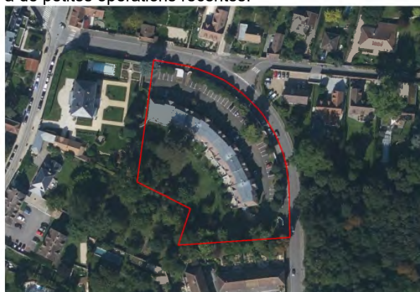
Résidence Les Orangers, 35 logements construits dans les années 90 – commune de Montfort-l'Amaury – Emprise foncière : 7 178 m 2 ; COS = 0,49 ; CES : 0,16 ; densité résidentielle : 50 lgt/ha.
