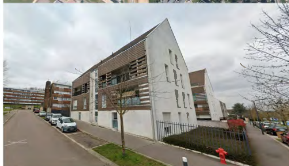
ZAC du Clos du Bois, PRU réalisé en 2010 au sein de la Résidence du Parc (400 logements) comprenant la démolition-reconstruction de 210 logements et la réhabilitation-résidentialisation de 100 logements – opération de 32 nouveaux logements sous forme de petits collectifs – 15 rue des Roussières, commune d'Ecquevilly
