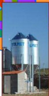
Silos de Chapa Galvanizada
