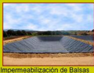
Impermeabilización de Balsas
