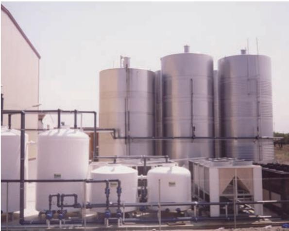
Termofriger realiza cualquier tipo de instalación según la específicas necesidades de sus clientes. Es el caso de las unidades enfriadoras de agua para control de la temperatura de fermentación de mostos y para la refrigeración del vino o de los mostos por medio de intercambiadores o en depósitos de acero inoxidable.
