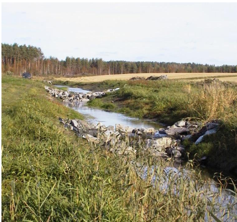
Fangdam ved Skottasjøen.
