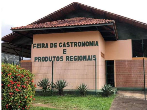
Figura 128: Sede da Feira de Gastronomia e produtos regionais de Silves/AM. Fonte: Ambipar Response Control Environmental Consulting S.A., 2022.
