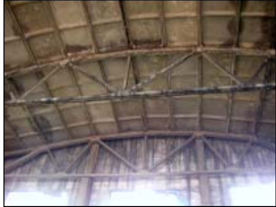
原有厂房内景：混凝土预制顶棚
