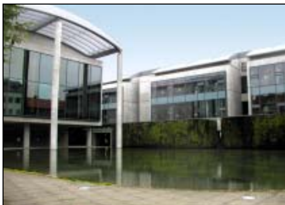
西面大玻璃窗上的固定遮阳
