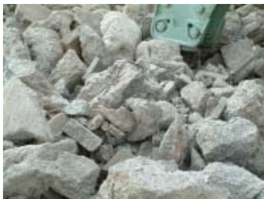
图 9 生产再生骨料的原材料 - - 旧混凝土块
