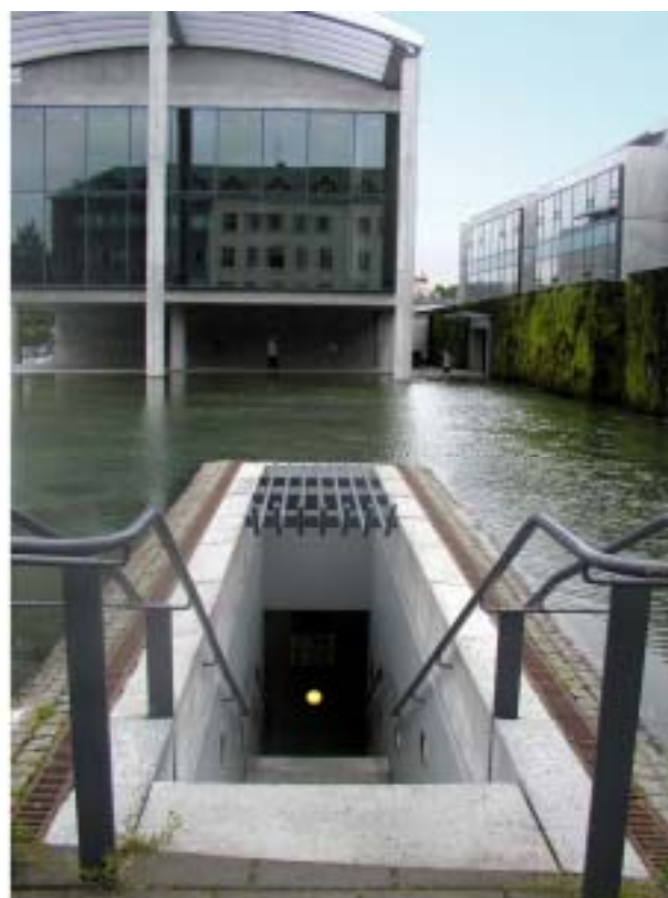
地下室紧急出口隐于水面以下
