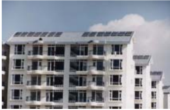
图2 太阳能热水器与建筑一体化示范小区—昆明红塔金典园住宅区
