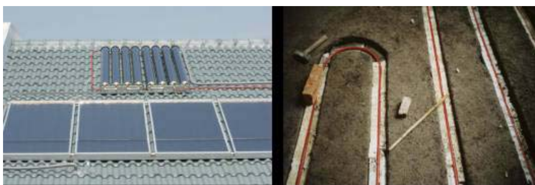
图4 太阳能地板采暖复合热水系统
