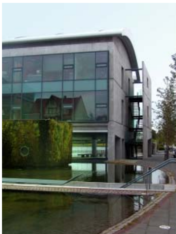
西端的疏散楼梯
