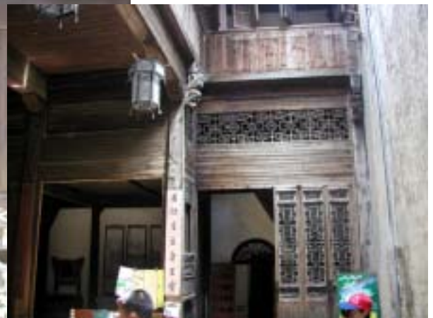
江浙民居：起居空间与天井结合；高窗通风
