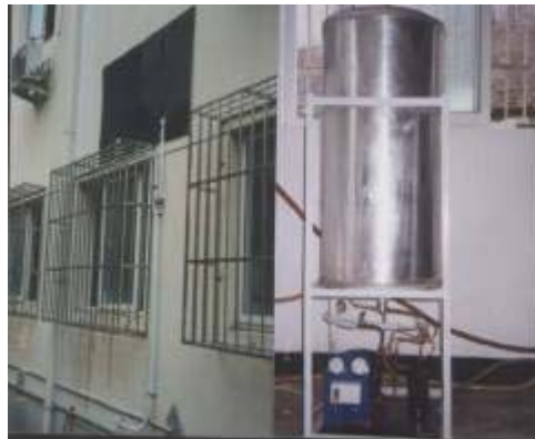
图3 直膨式太阳能热泵热水器
