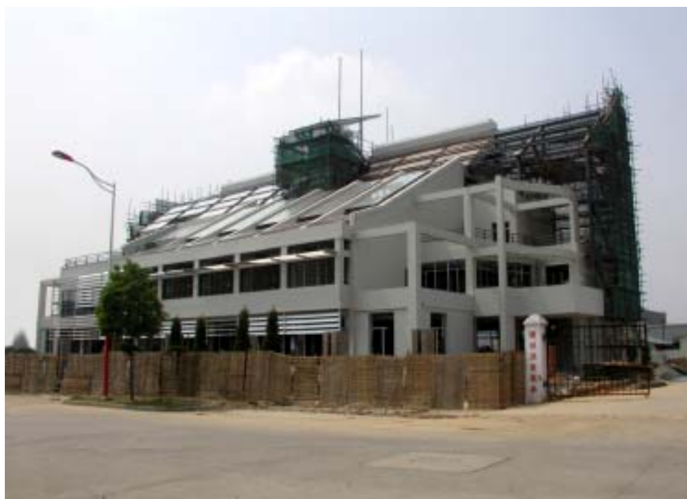
8月中旬施工现场
