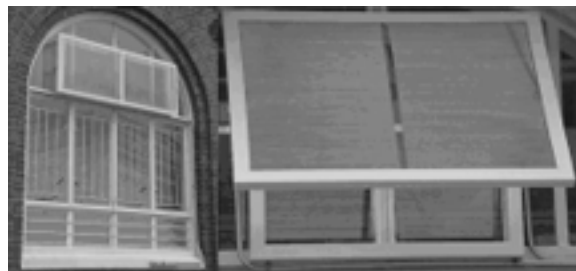
图 2 澳大利亚昆士兰科技大学研究以激光准确切割的透明反光板
