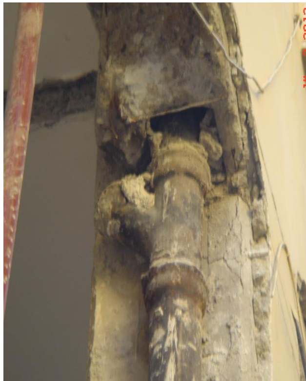
Foto 4 – immagine di un pilastro al 2° piano in stato di degrado estremo
