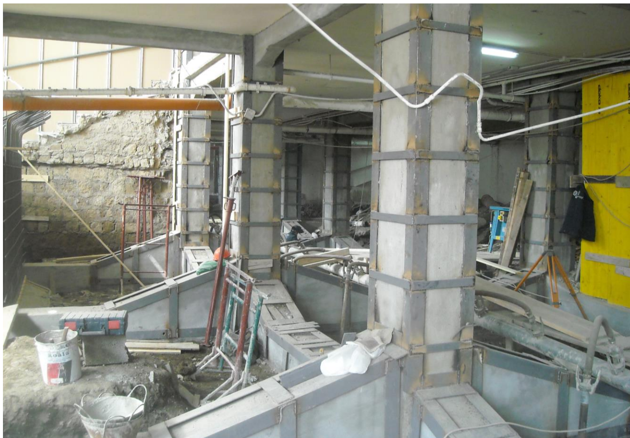
Foto 3 – fase di consolidamento delle travi rovesce in fondazione
