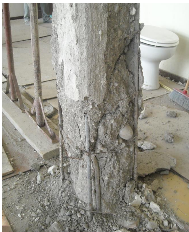
Foto 4 – immagine di un pilastro al 2° piano in stato di degrado estremo
