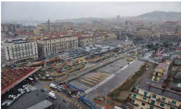
Lavori in corso per la riqualificazione di piazza Garibaldi
