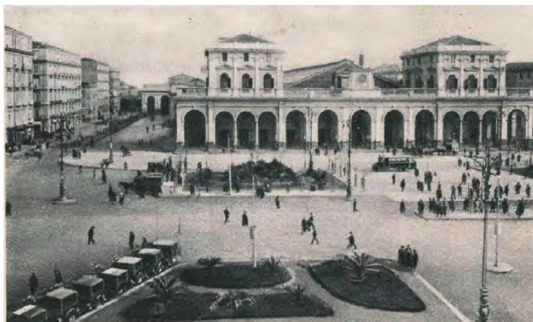
La vecchia Stazione Centrale di Napoli
