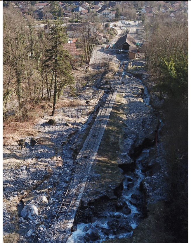
▲ Visite de terrain du 30 décembre 2021 par les élus des communes de Crolles, Lumbin, du Plateau-des-Petites-Roches, le SYMBHI et le service RTM de l'Isère. Les divagations du torrent et les ravinelements associés ont entraîné de lourds dégâts structurels sur la ligne du funiculaire – vue depuis l'amont.
