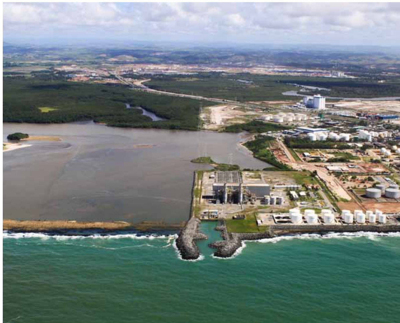
Figura 103 – Molhes enrocados formando área abrigada da ação direta das ondas. Porto de Suape, litoral sul.
