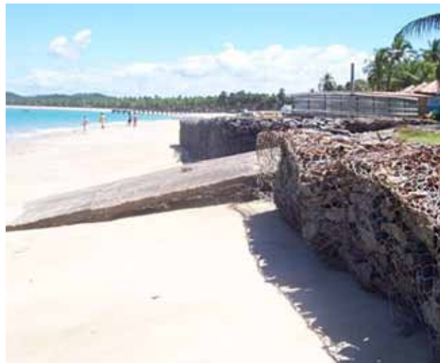
Figura 17 - Gabiões para contenção do processo erosivo. Tamandaré, litoral sul.
