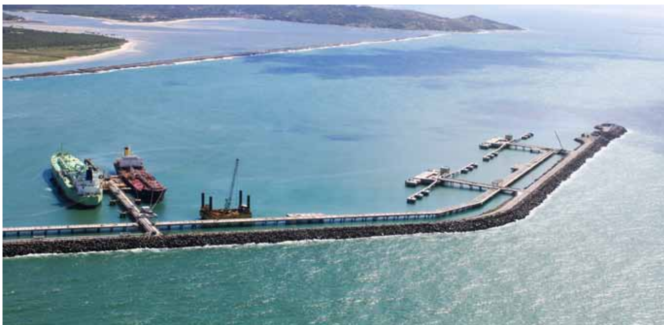
Figura 74 – Piers de atracação junto ao Porto de Suape.
