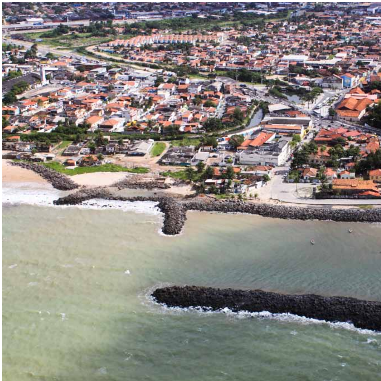
Figura 14 – Conjunto de obras costeiras (enrocamento, molhes e quebra-mar) construídas no intuito de proteger a costa da ação erosiva das ondas e marés. Praia dos Milagres, Olinda, litoral central.
