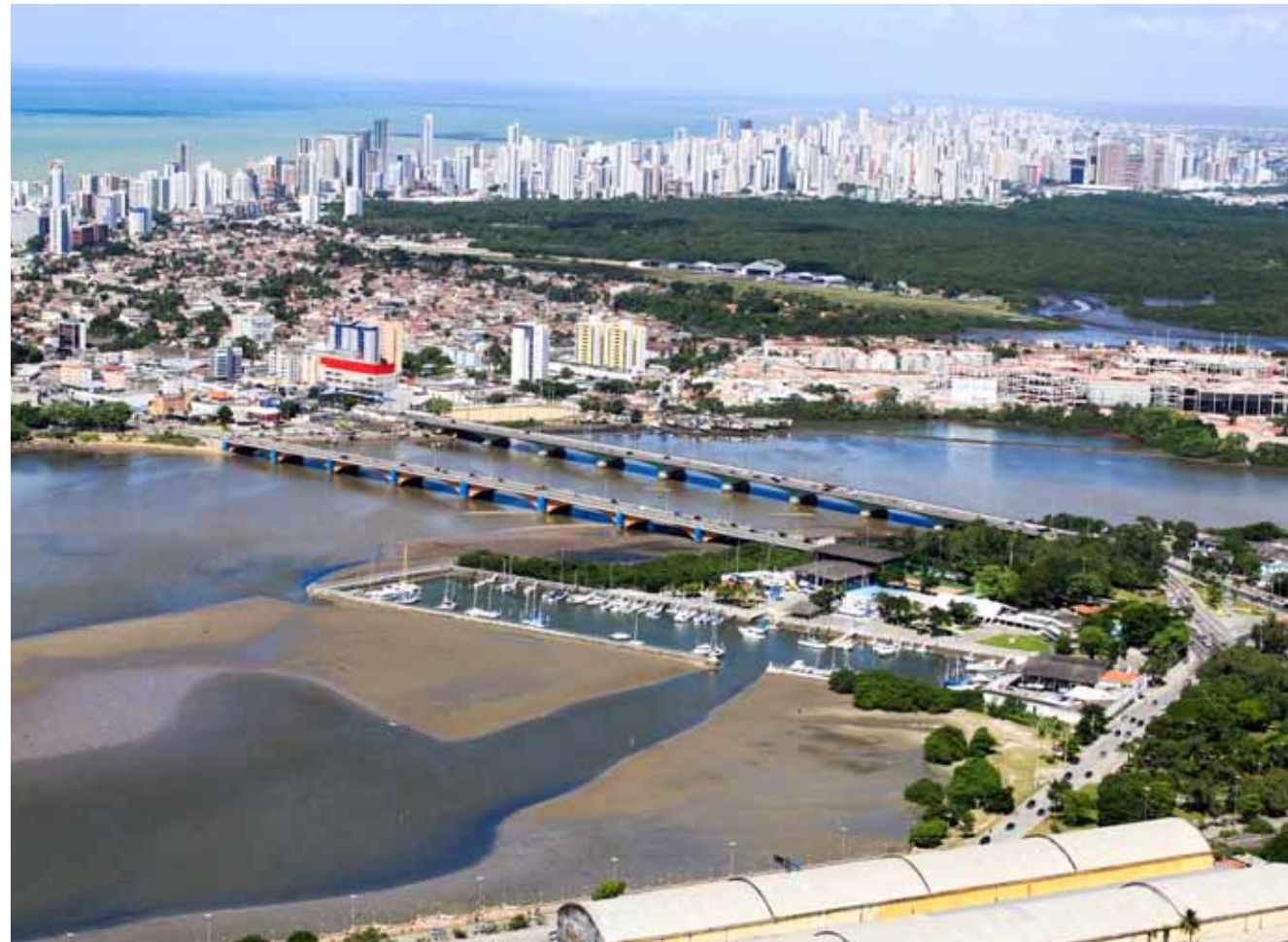
Figura 61 – Imagem que resume a diversidade de usos da zona costeira: moradia (bairros do Pina e Boa Viagem), navegação (Cabanga late Clube), preservação ambiental (Parque dos Manguezais) e turismo (Praia de Boa Viagem, ao fundo). Recife, litoral central
