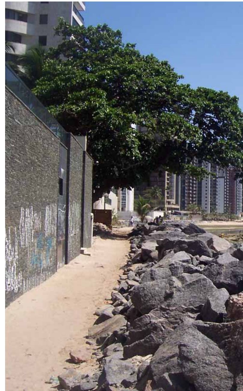
FIGURA 19 - Enrocamento aderente. Praia de Piedade, Jaboatão dos Guararapes, litoral central.
