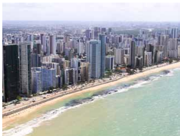
Figura 97 – Trecho de litoral protegido por enrocamento aderente exposto. Praia de Boa Viagem, Recife, litoral central.
