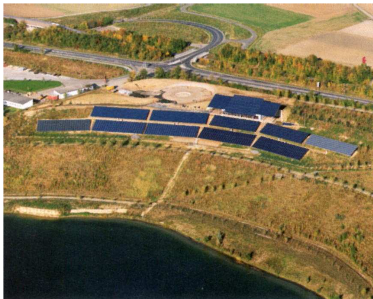
Abbildung 8.23: Solarkraftwerk Neurathersee mit 360 kWp Leistung [4]
