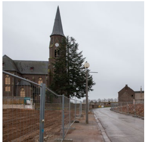
Abbildung 3: Die Häuser in Manheim im Rheinischen Braunkohlegebiet stehen kurz vor dem Abriss für den Tagebau (Foto: Anja Schmid-Engbrodt, Archiv des Alltags im Rheinland, ase20200127-006).
