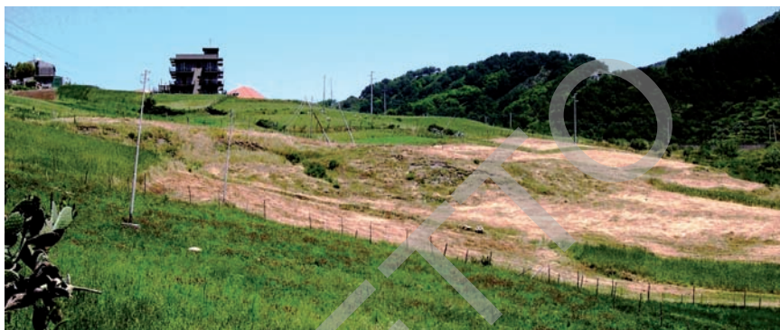
Fig. 76 – Fenomeni di smottamento diffuso nelle argille scagliose (ASI) all'interno del graben di Case Migliardo a sud-est di Monte S. Croce.
