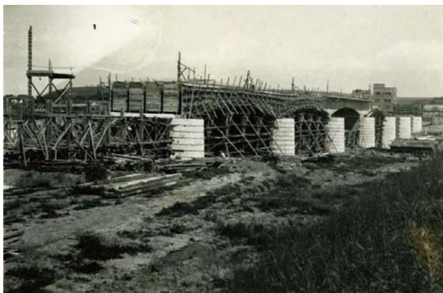
Fig. 5 - Impalcature e piloni di sostegno del ponte (Fondo Enrico Ricci, scattata il 6 maggio 1940).
