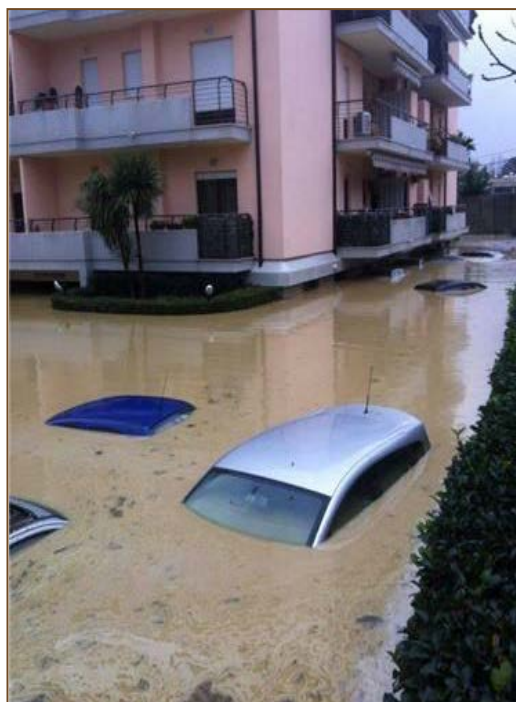
Pescara 2/12/2013. Allagamento in via del Circuito, a seguito dell'esondazione del fiume Pescara (foto: E. Juliano)
