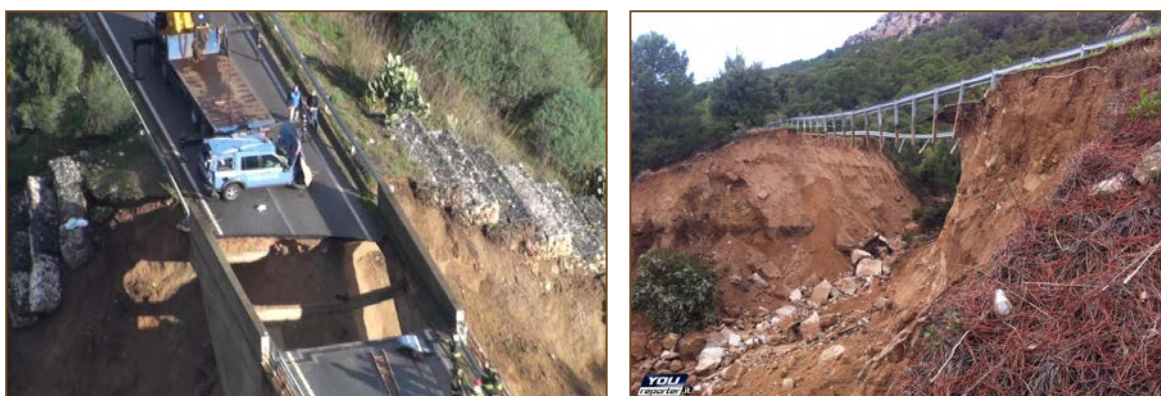
Olbia, 19/11/2013. Crollo del Ponte Oloè, S.P. n. 46 Oliena-Dorgali (a sinistra) (1 vittima); forti fenomeni erosivi in corrispondenza di un piccolo corso d'acqua, S.P. n. 38 Olbia-Tempio (a destra)(3 vittime); (foto: Regione Autonoma della Sardegna)
