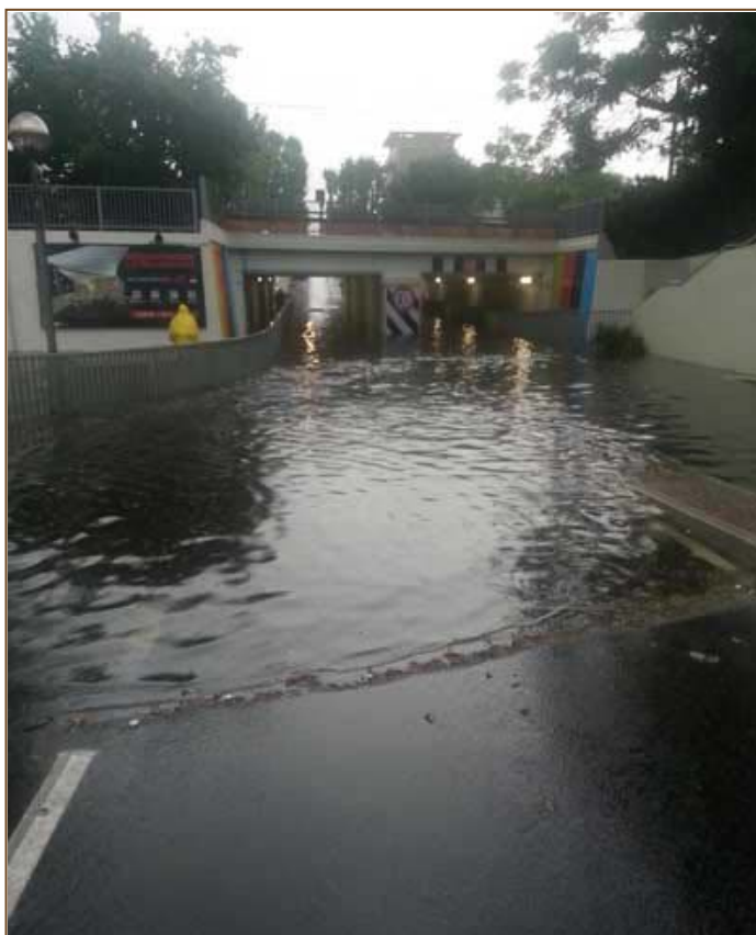
Rimini, 25/6/2013. Allagamento del sottopasso di Viale Tripoli (foto: Comune di Rimini)
