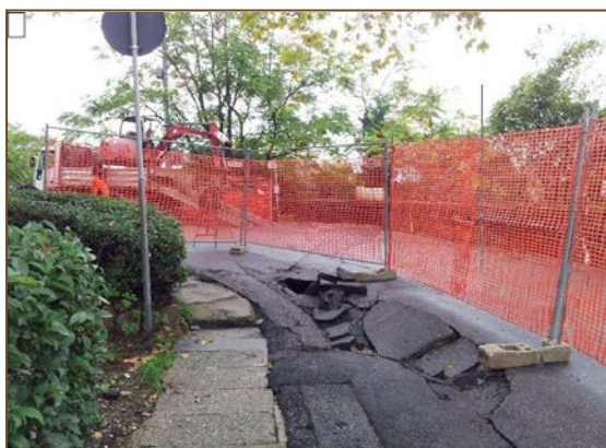
La Spezia, 24/10/2013. Sprofondamento della carreggiata in Loc. Pegazzano (a sinistra, foto: Archivio Cds); collasso della volta per sovrappessione del Canale Cantarana in Loc. Chiappa (a destra, foto: T.D.L).
