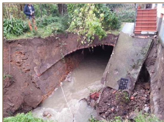
La Spezia, 24/10/2013. Sprofondamento della carreggiata in Loc. Pegazzano (a sinistra, foto: Archivio Cds); collasso della volta per sovrappessione del Canale Cantarana in Loc. Chiappa (a destra, foto: T.D.L).
