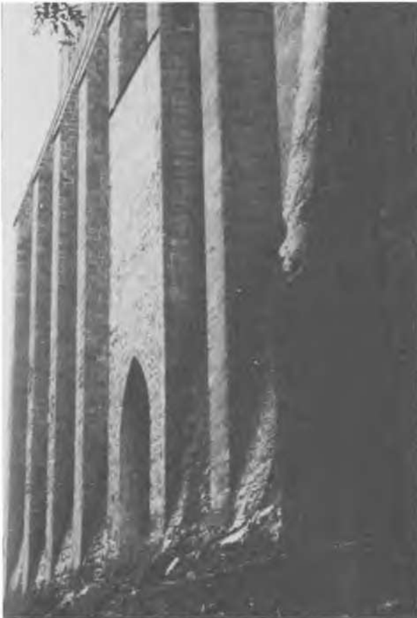
Fig. 54 - Buttresses of La Merveille.
